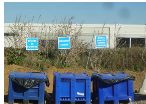
Photo 24 : Mise en place d'un tri des déchets (Source : chantier élargissement A9, setec)
