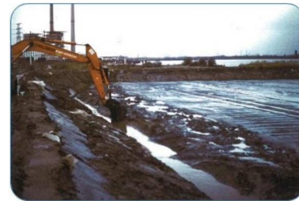
Figure 4 : Assèchement des matériaux de dragage (Source illustration : AVP – TEAM'O+, 2018)
