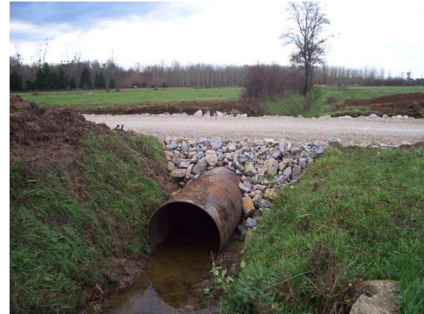
Photo 11 : Ouvrage hydraulique provisoire sous la piste de chantier
