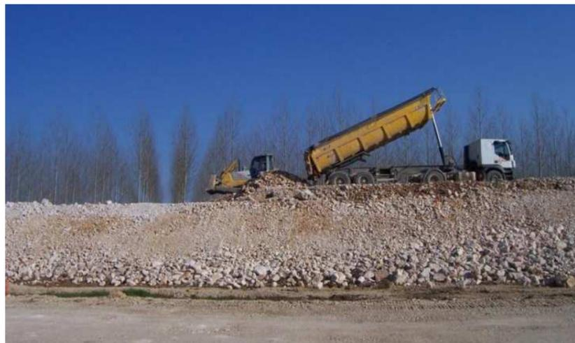
Photo 7 : Mise en œuvre de matériaux de préchargement
