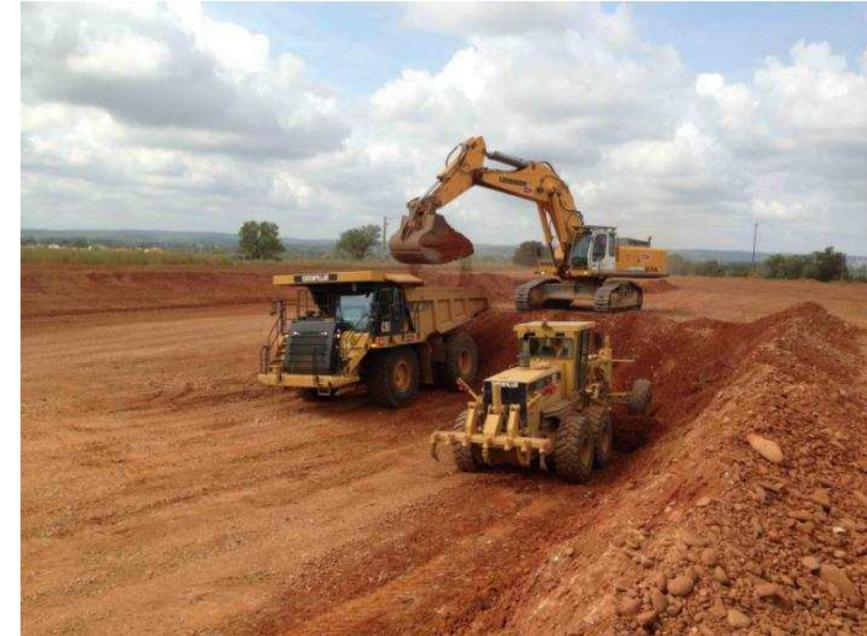
Photo 5 : Opération de terrassement (Source : chantier CNM, setec)
