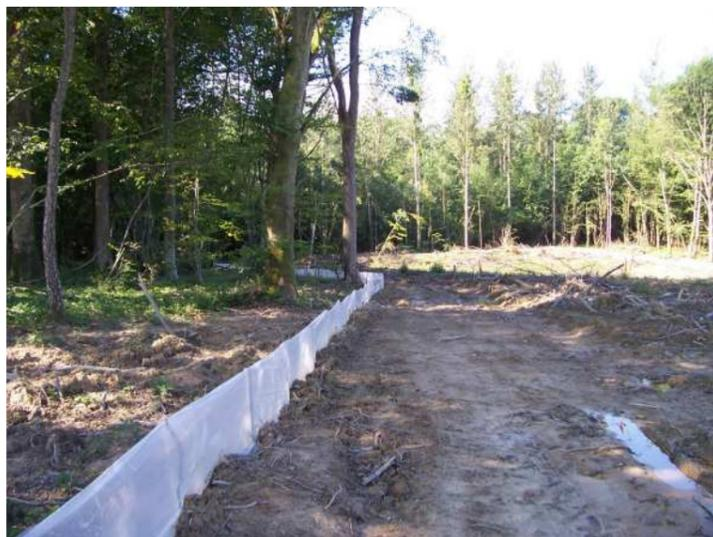
Photo 16 : Mise en place de bâches de protection contre les amphibiens
