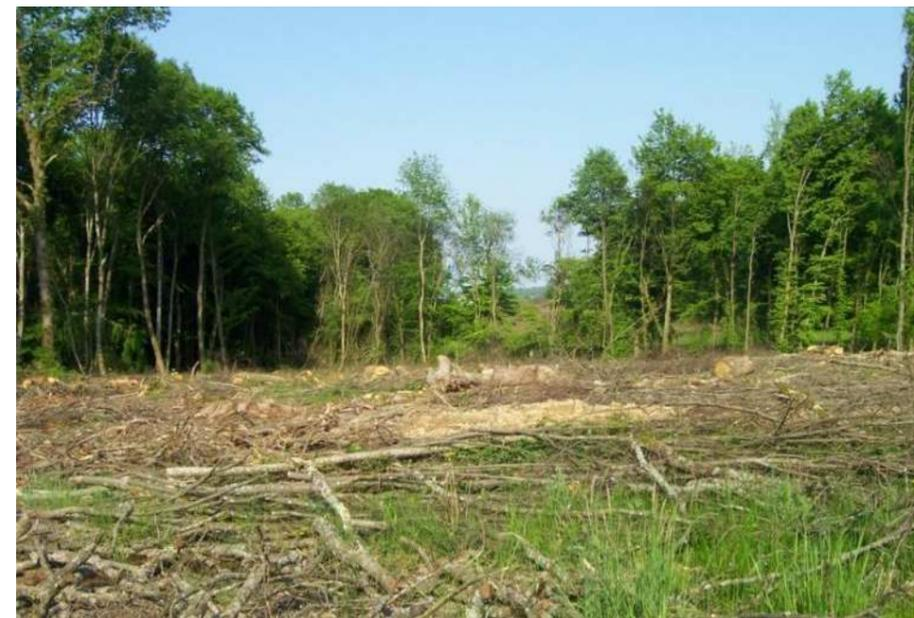
Photo 18 : Exemple de défrichage (Source : chantier LGV Rhin-Rhône, setec)
