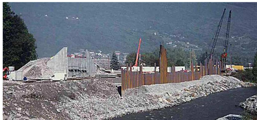
Photo 6 : Battage de palplanches (Source setec)
