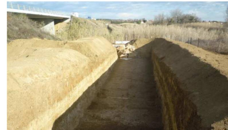
Photo 9 : Bassin de décantation avec filtre à cailloux (Source : chantier élargissement A9, setec)
