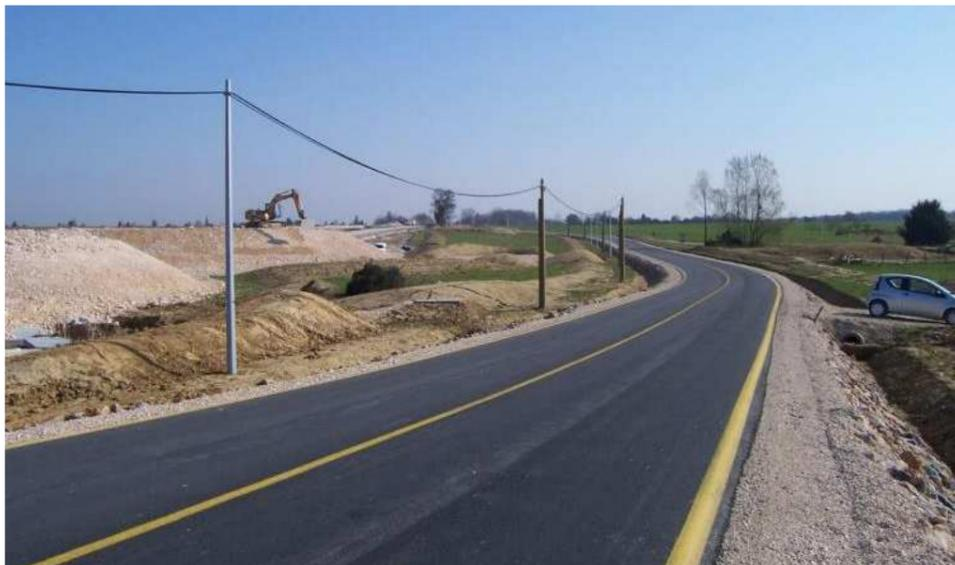
Photo 19 : Mise en place dérivation de route (Source : chantier LGV Rhin-Rhône, setec)
