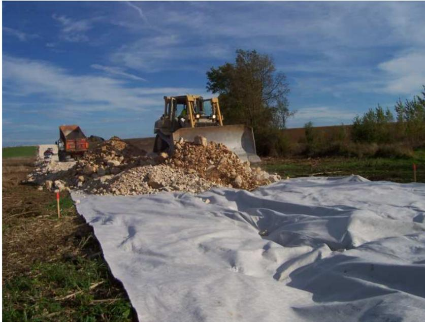
Photo 14 : Mise en place d'un géotextile dans la traversée d'une zone humide
