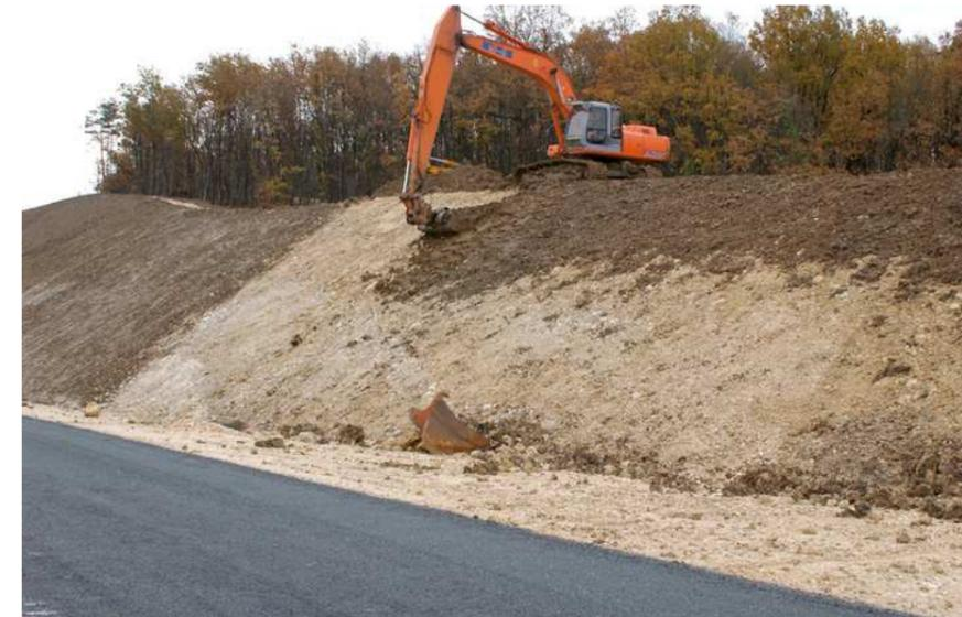
Photo 13 : Mise en œuvre de terre végétale en limite des boisements conservés (source : setec)
