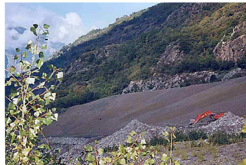
Photo 15 : Mise en place de terres végétales sur un dépôt de 1 M de m<sup>3</sup> (source : setec)
