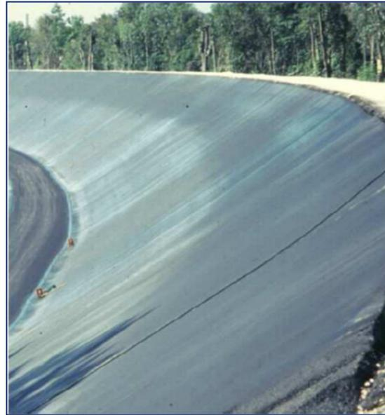
Figure 48: Béton Bitumineux. source E.ON SE
