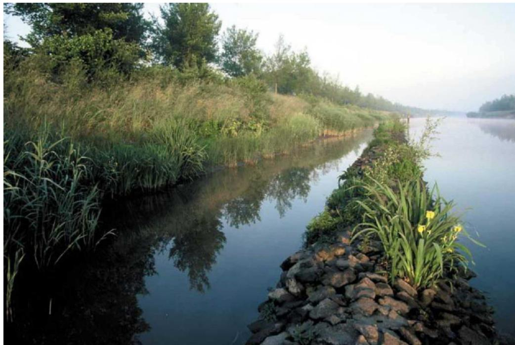
Figure 79 : Berge lagunée sur un canal à grand gabarit (photo : SETEC International)
