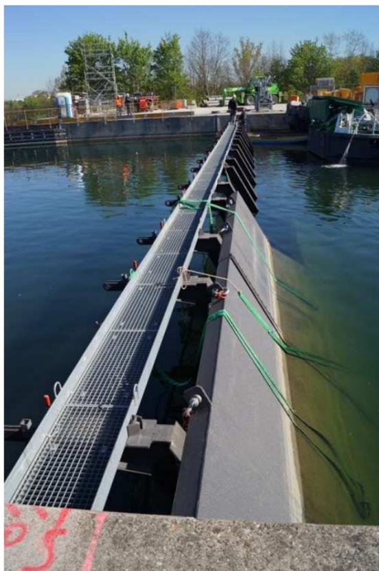
Photo 7 : Exemple de barrière étanche utilisée sur les ouvrages de transitions des ponts canaux du canal Main-Danube
