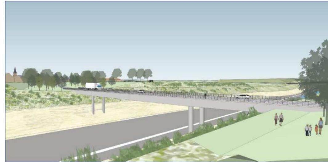
Figure 60: Rétablissement de la RD7E à Ytres - par un bipoutre mixte
