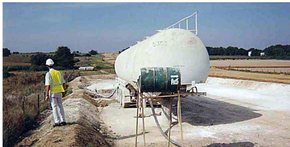
Photo 5 : Citerne de distribution de chaux pour traitement des sols (source : setec)
