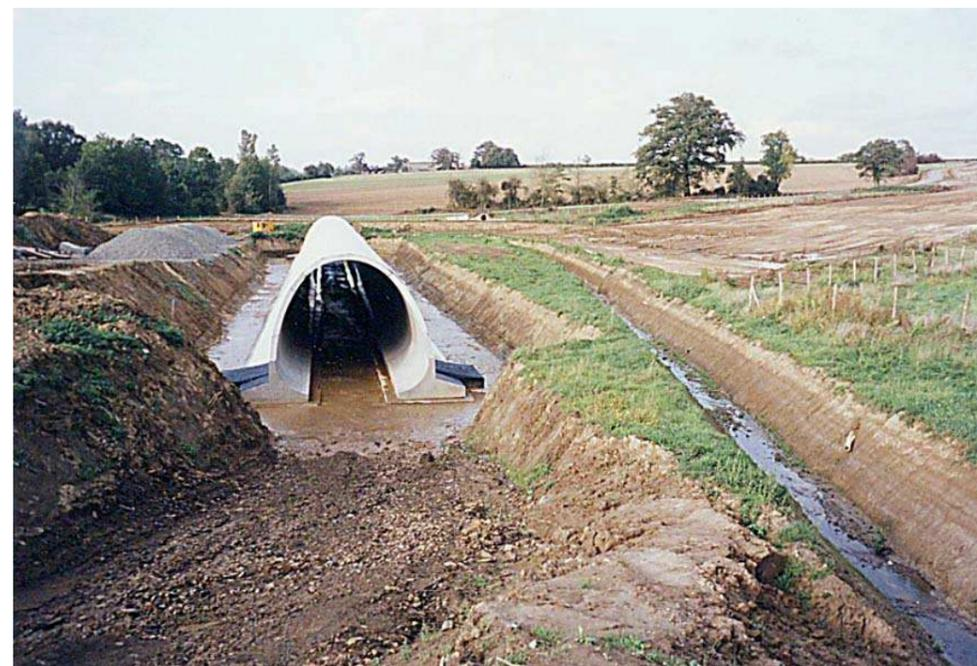
Photo 11 : Déviation provisoire pour la construction d'un ouvrage hydraulique (source : setec)
