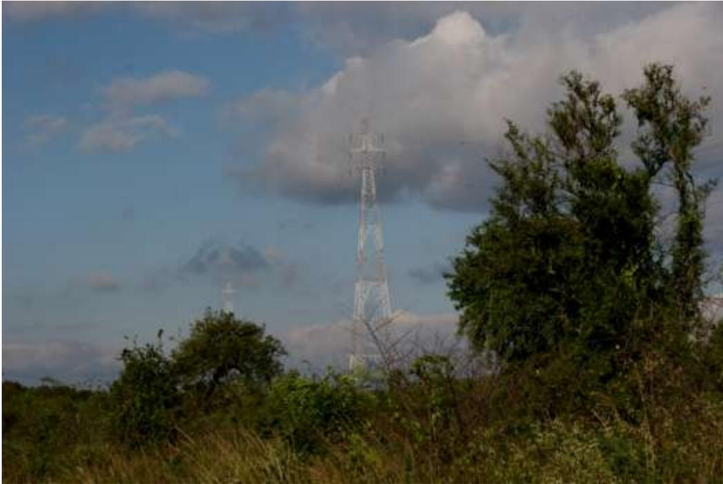
**Foto 111** – Torres especiales de la línea de 220 kV para el cruce del Río Paraguay.
