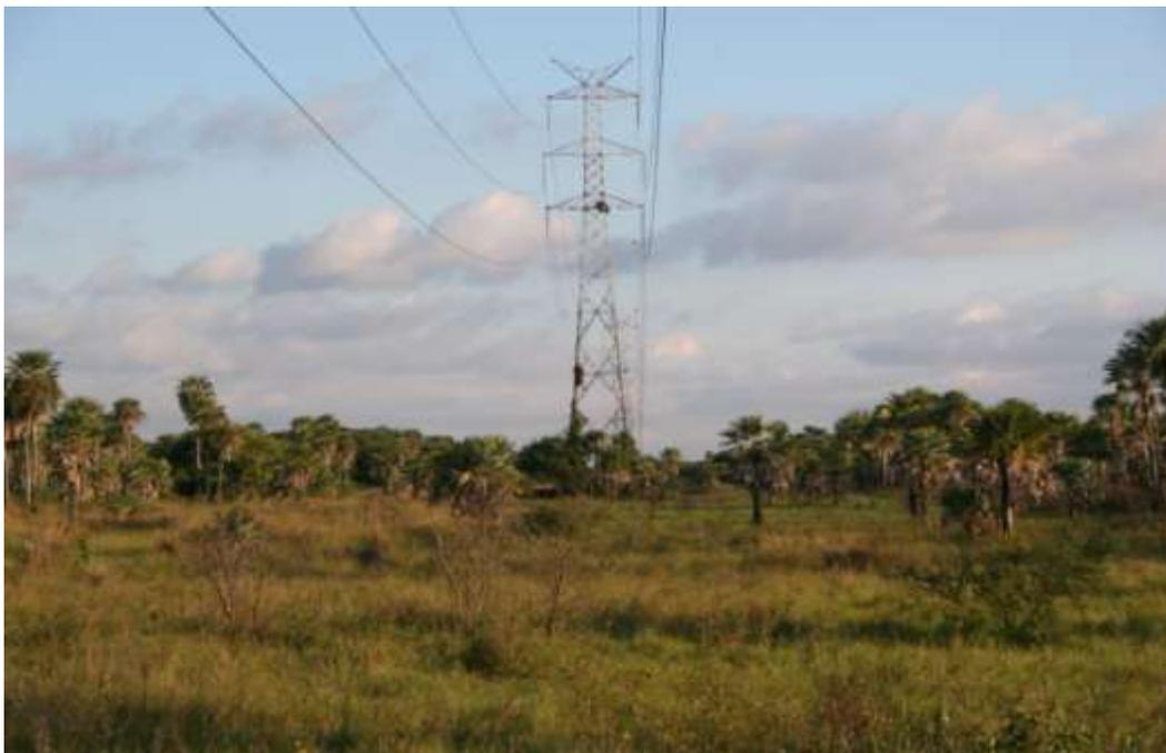
**Foto 122** – Vista hacia el Norte de la actual línea 220 kV. Se observa el crecimiento de la vegetación dentro de la franja de servidumbre como así también la formación de nidos en diferentes alturas de la torre metálica.
