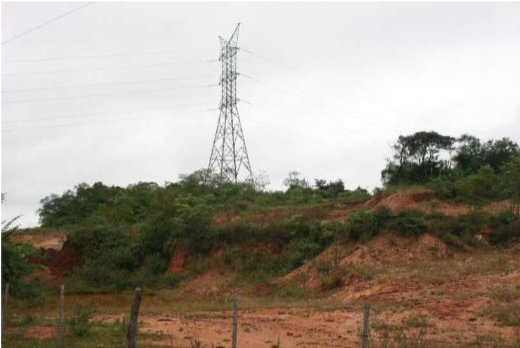
**Foto 71** – Vista de la cantera por donde pasa la línea. Se puede apreciar el crecimiento de la vegetación debajo de la estructura metálica de la línea.
