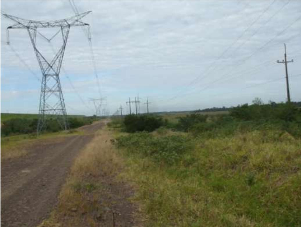
**Foto 5** – Líneas existentes que se encuentran dentro de la isla. Son líneas de E.A.T 500 kV, A.T 220 kV, media y baja tensión.
