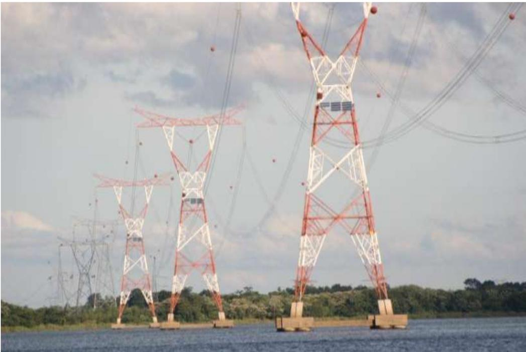
**Foto 10** – Cruce de la línea de 500 kV por uno de los brazos del Río Paraná. En frente se observa la isla y la Reserva Natural Yacyretá.
