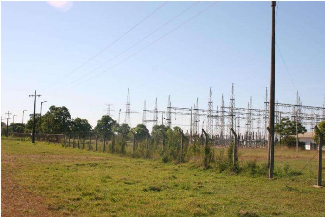
**Foto 28** – Vista de la salida de las dos líneas de 220 kV (una simple terna y otra doble terna) desde la E.T. Ayolas.
