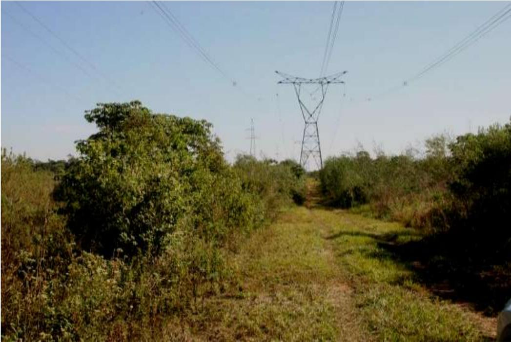
**Foto 9** – Vista del camino y de la franja de servidumbre de la actual línea de 500 kV. Se puede observar un avanzado crecimiento de la vegetación.
