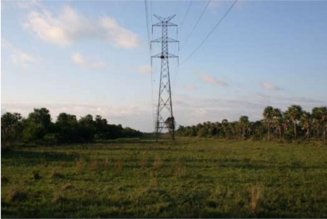
**Foto 123** – Vista hacia el Sur de la línea existente. Se observa la franja de servidumbre sin vegetación arbórea o arbustiva.
