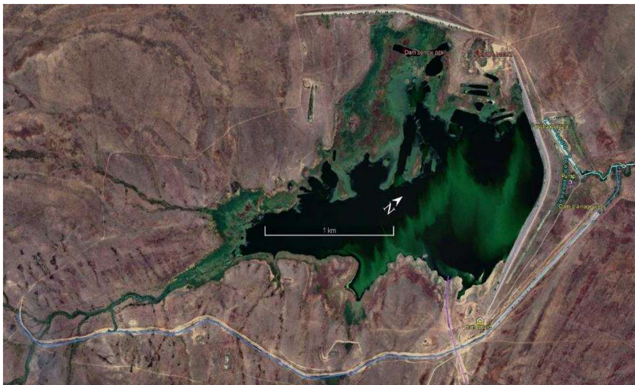
Рис. 6.26 Крупный план уравнильного резервуара (УРЕ) в октябре 2021 года. На нем показаны пара подземных входных труб (фиолетовые), обводной канал ручья, не связанный с входными трубами (темно-синий), нагнетательные ворота и канал (синие), дренажные колодцы плотины и насос для возврата дренажных вод и сторожка. Уровень воды самый высокий в марте и самый низкий в мае. Некоторые карьеры, вырытые для строительства плотины, заполняются активным илом с иловых площадок КОС.
