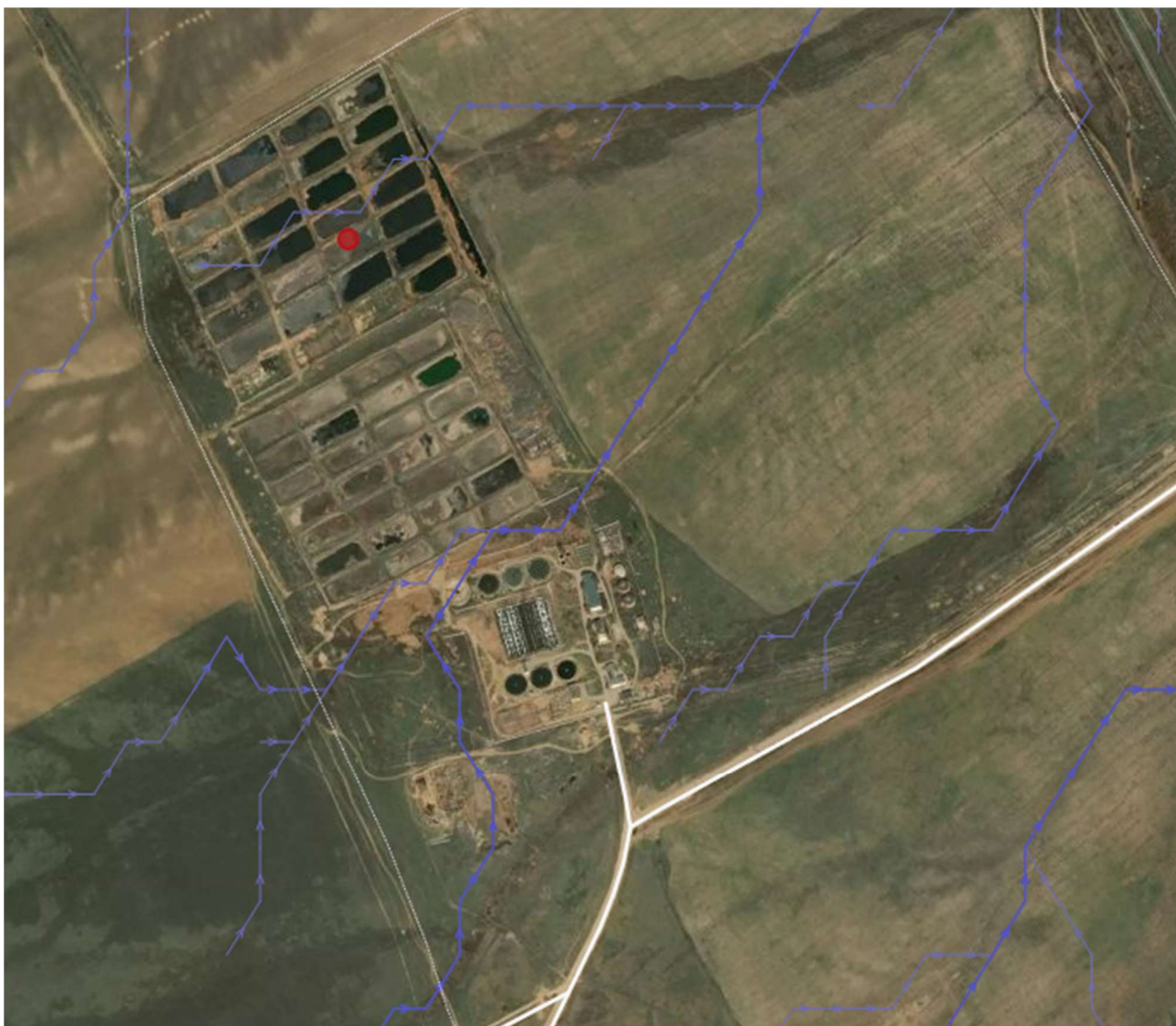
Рисунок 8.3: Пути течения (синие линии), показывающие, где будет проходить поверхностный сток в районе старой и предлагаемой новой водоочистной станции.
