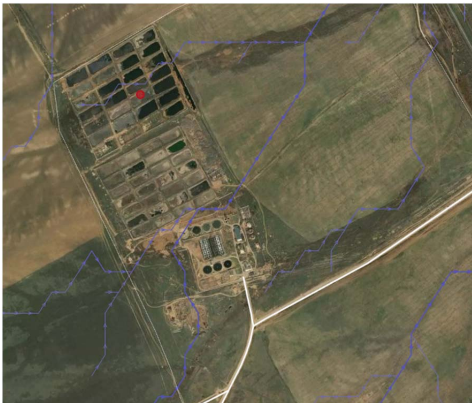
Сурет 8.1: Ескі және ұсынылған жаңа КТҚ аймағында жер үсті ағынының қай жерде өтетінін көрсететін ағын жолдары (көк сызықтар).
