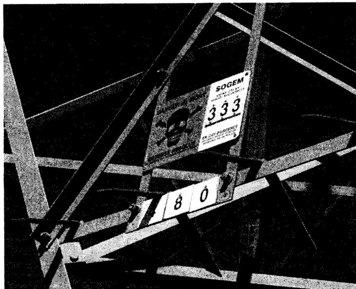
Figure 11 : Exemple de plaque signalétique (source : Tractebel Engineering)
