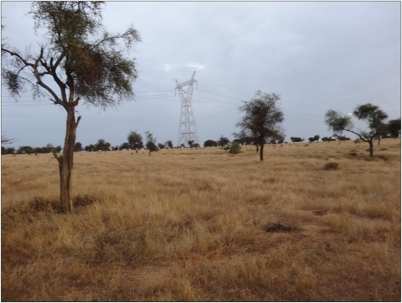
Photo 24 : Ligne OMVS – à proximité du lac de Guiers
