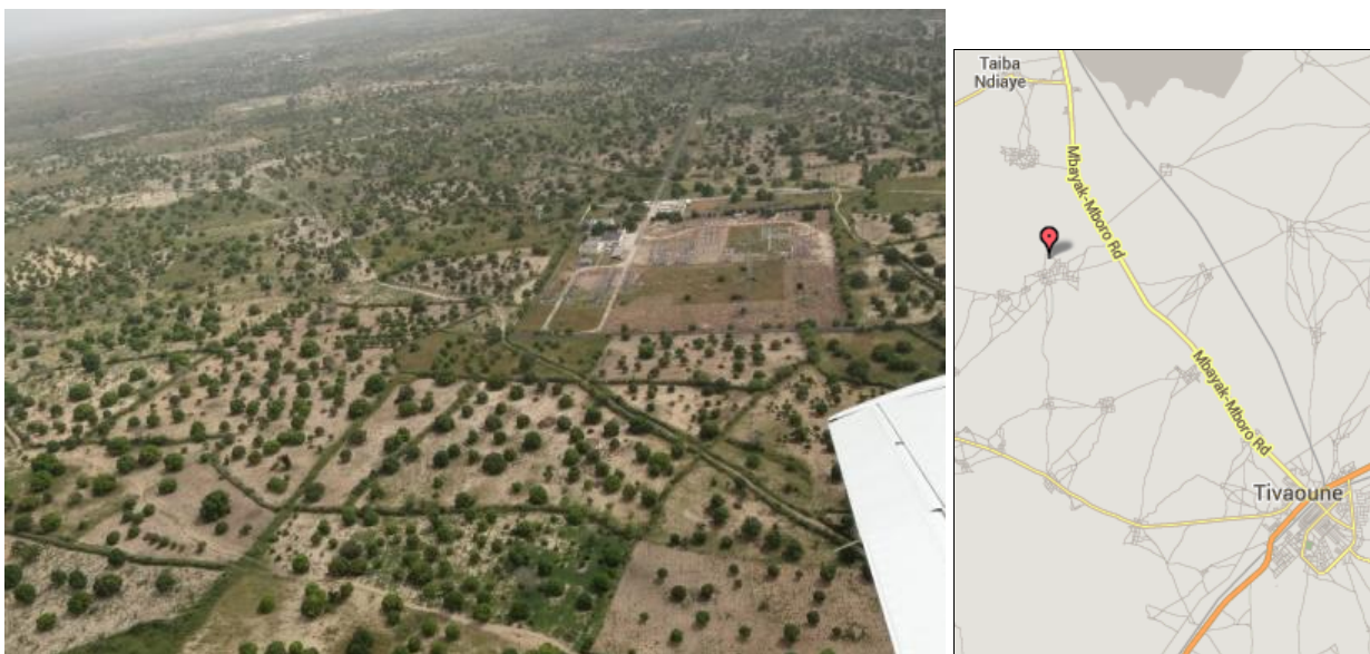
Photo 5 : Tracé tronçon 3 (Poste de Tobène)
