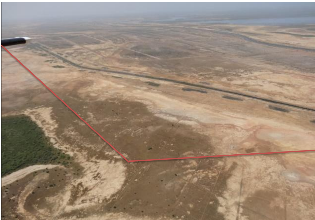
Photo 15 : Zone du tracé tronçon 2b (Passage de la ligne)
