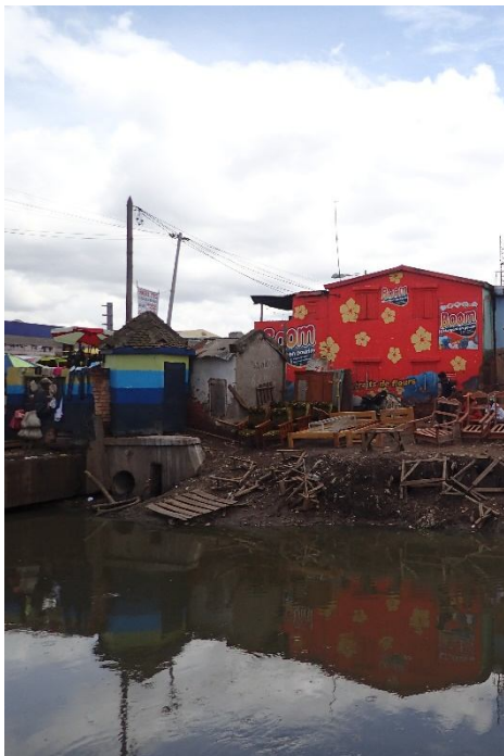
Photo 9: Borne fontaine à reconstruire - Pont Jovenna
