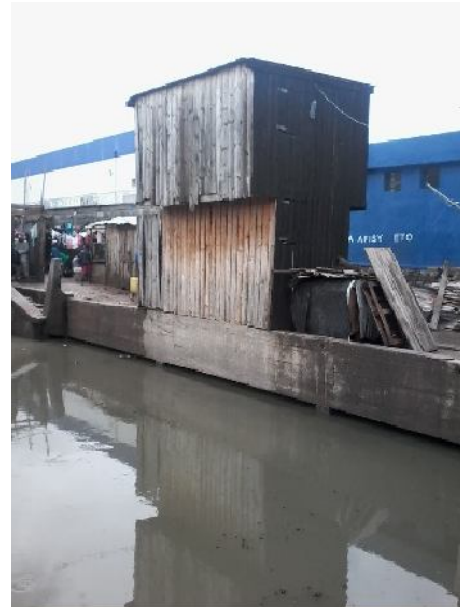
Photo 5: Exemple de bâti dur touché en bordure du canal C3
