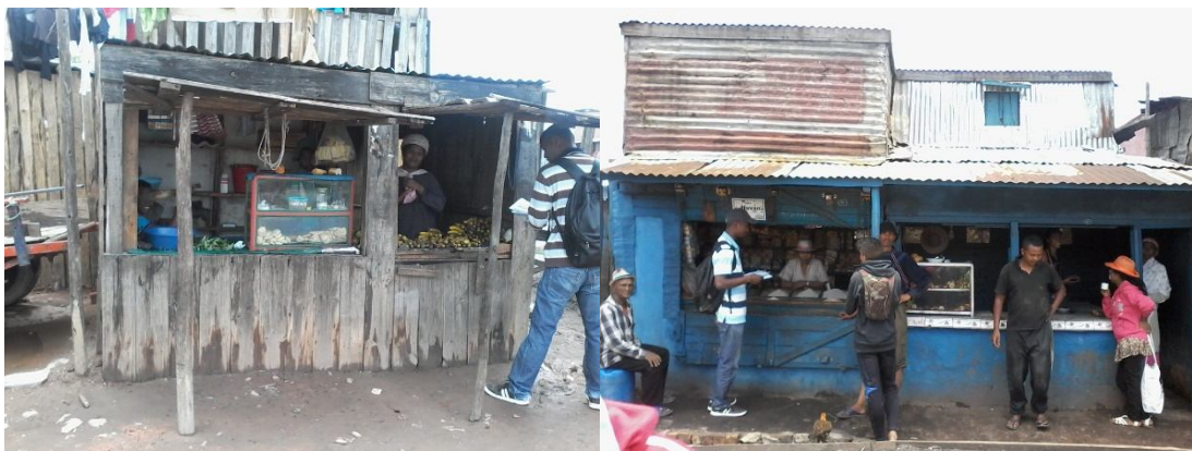
Photo 6: Exemple de bâti commercial, à gauche : en dur: Epicerie-gargote ; à droite, en structure légère
