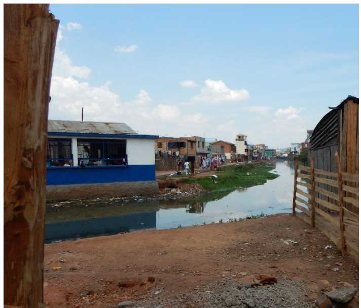
Photo 10: Lavoir d'Ankasina à reconstruire
