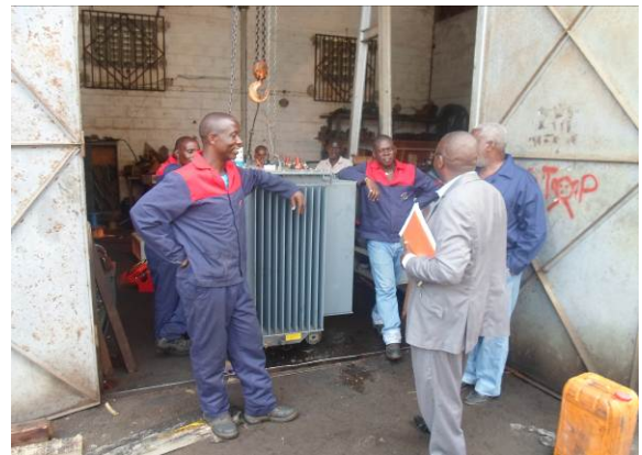
Installations à la SNE de Pointe Noire
