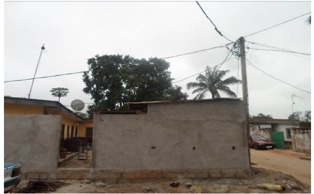
Réseau électriques Pointe noire
