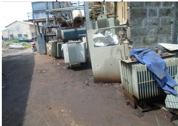
Installations à la SNE de Pointe Noire
