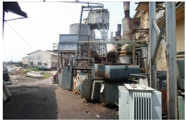
Installations à la SNE de Pointe Noire
