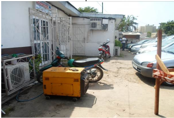
Groupe électrogènes à défaut délectricité
