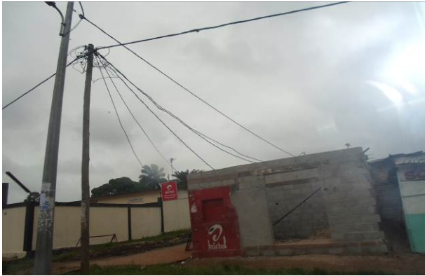
Réseau électriques Pointe noire
