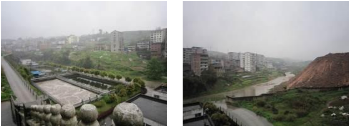
图 5.3.7-1 邻水县第一污水处理厂现状
