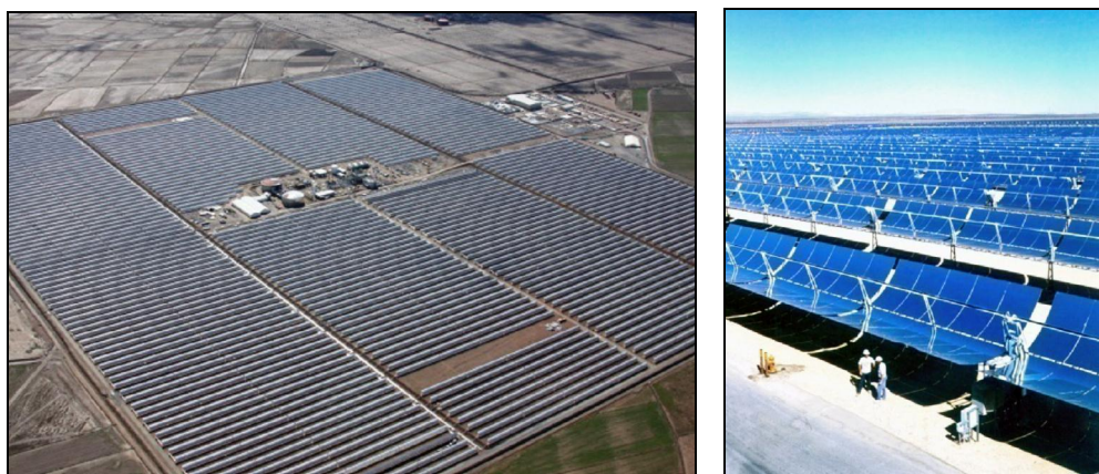
Figures 30 : Exemple de centrales à capteurs cylindro-paraboliques : Andasol 1 – Espagne (à gauche) et Solar Electric Generating Station VI – Etats-Unis (à droite)
