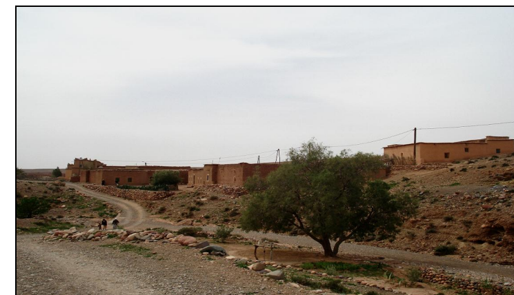
Photo 18 : Douar Tasselmente - Maisons électrifiées
