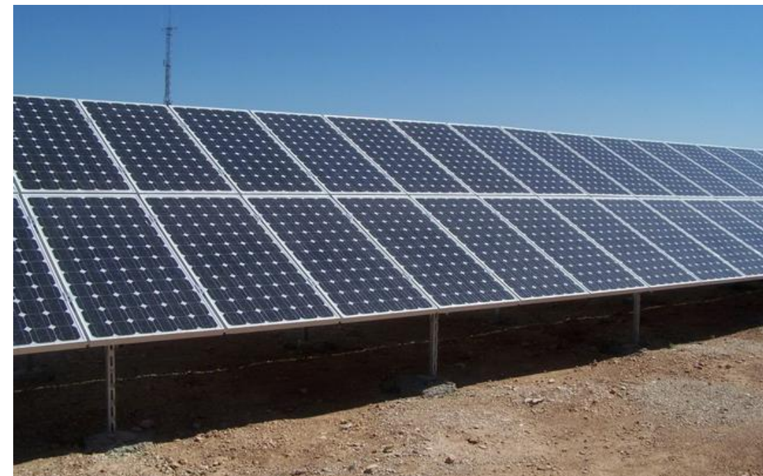
Figure 21 : Module utilisant des cellules monocristallines
