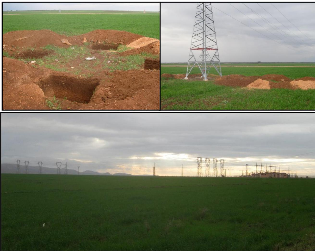
**Figure 6-19: En haut : Déblai du fondement des pylônes à coté du poste de Tazarte. En bas : Poste de Tazarte (Photo mission de terrain, Pöyry 24-28.01.2012).**
