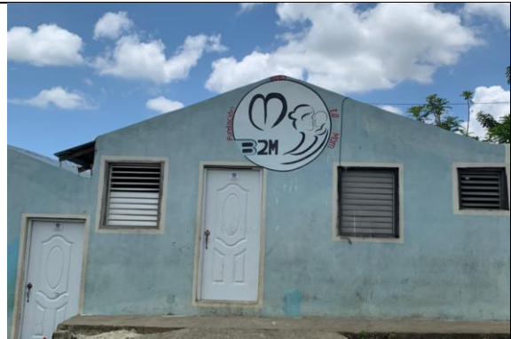
Foto 12: Casas de material noble de Fundación Coreana, entregada a los pobladores del sector. Fuente: JGP Consultoría (mayo/2022).
