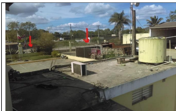
Foto 02: Vista cerca en fachada frontal del Vertedero.
