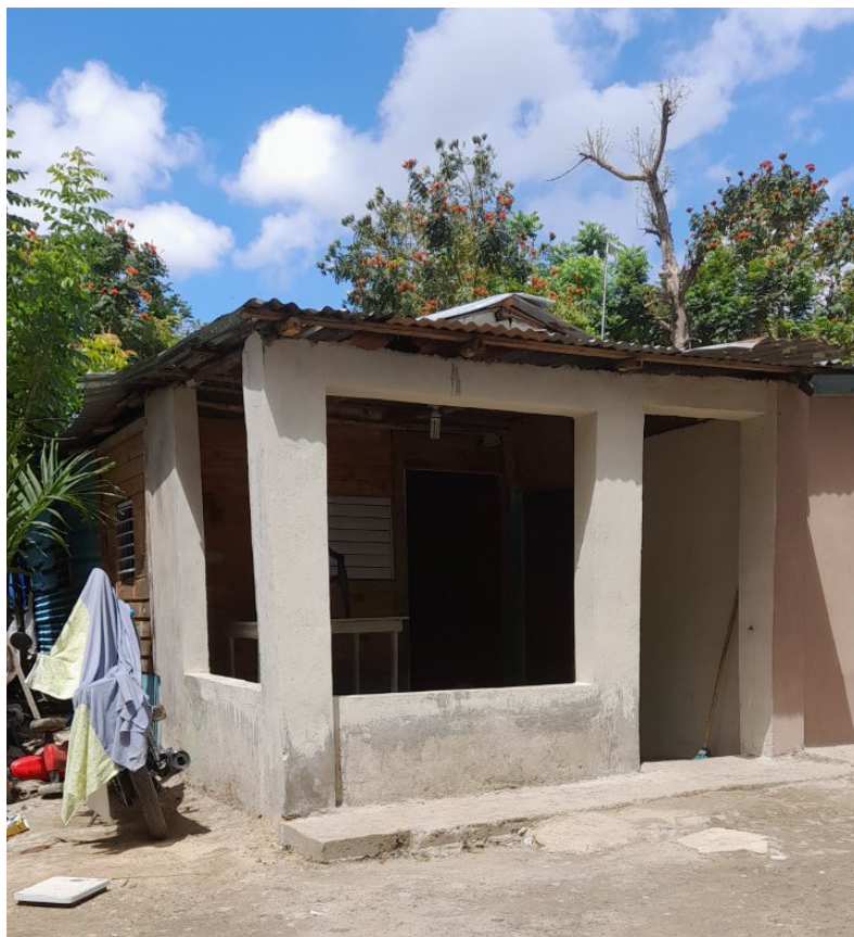
Imagen 4. Vivienda en el área de estudio con paredes de concreto. Fuente: propia.
