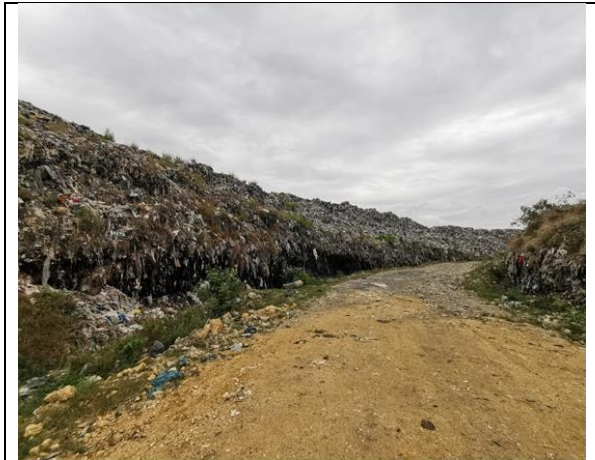
Foto 01: Condiciones actuales del camino.
