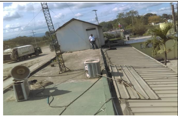
Foto 14: Vista general del techo Edificio Oficinas Comisión Administrativa, Área de peso y Encargado de Transportación. Se observa al fondo, caseta de vigilancia fuera de operación actualmente.
