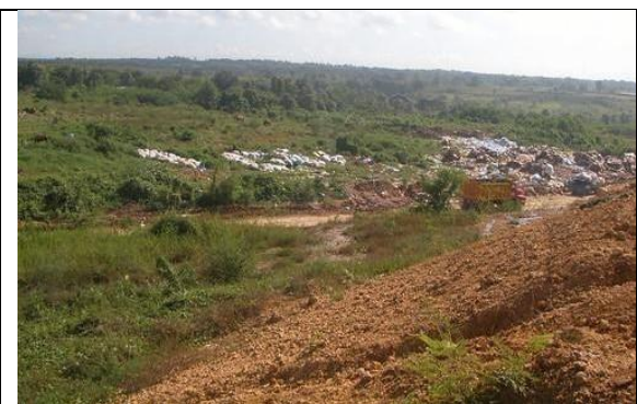
Foto 03: Vista general de la área al suroeste del Vertedero donde no hay cerca perimetral.
