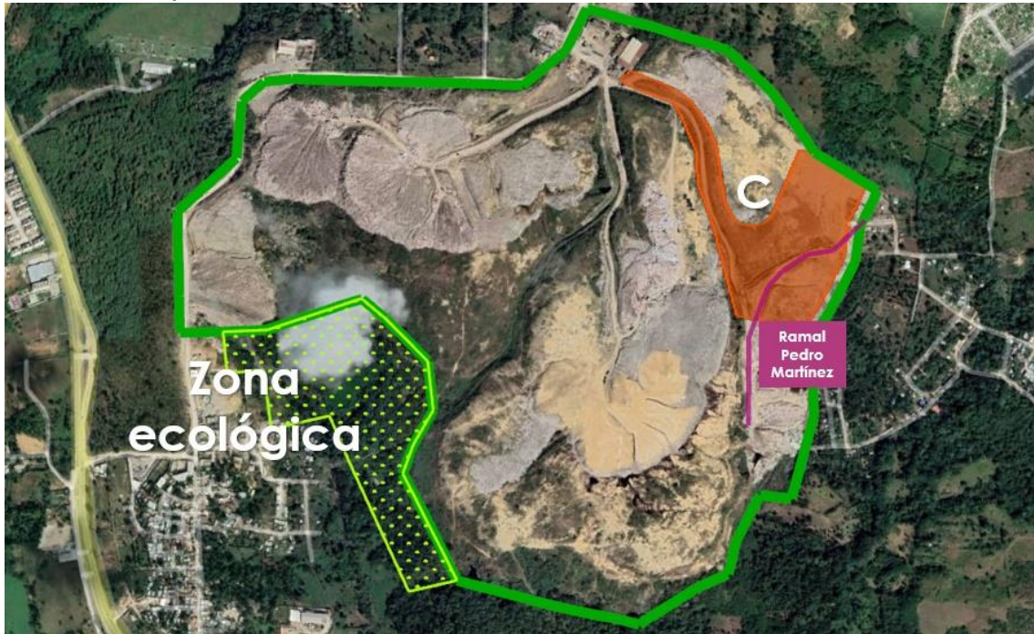
Figura 3.2.f Ramal interior para el Sector C
