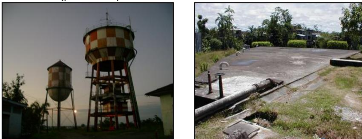
Figura 3.8. Tanque de Almacenamiento del Sistema de Acueducto
