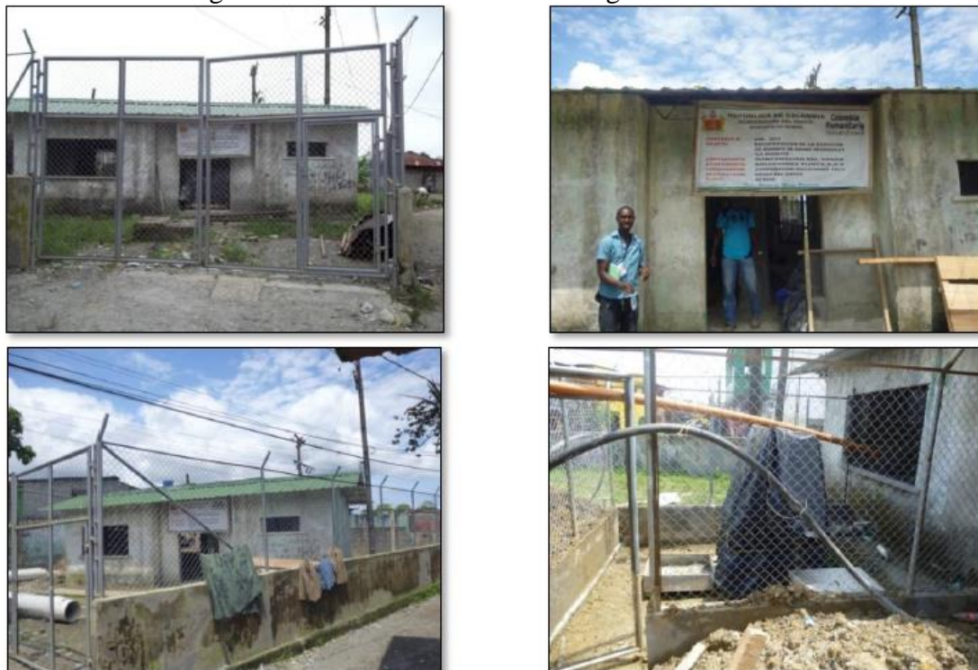
Figura 3.9. Estación de bombeo de aguas residuales La Bombita.
