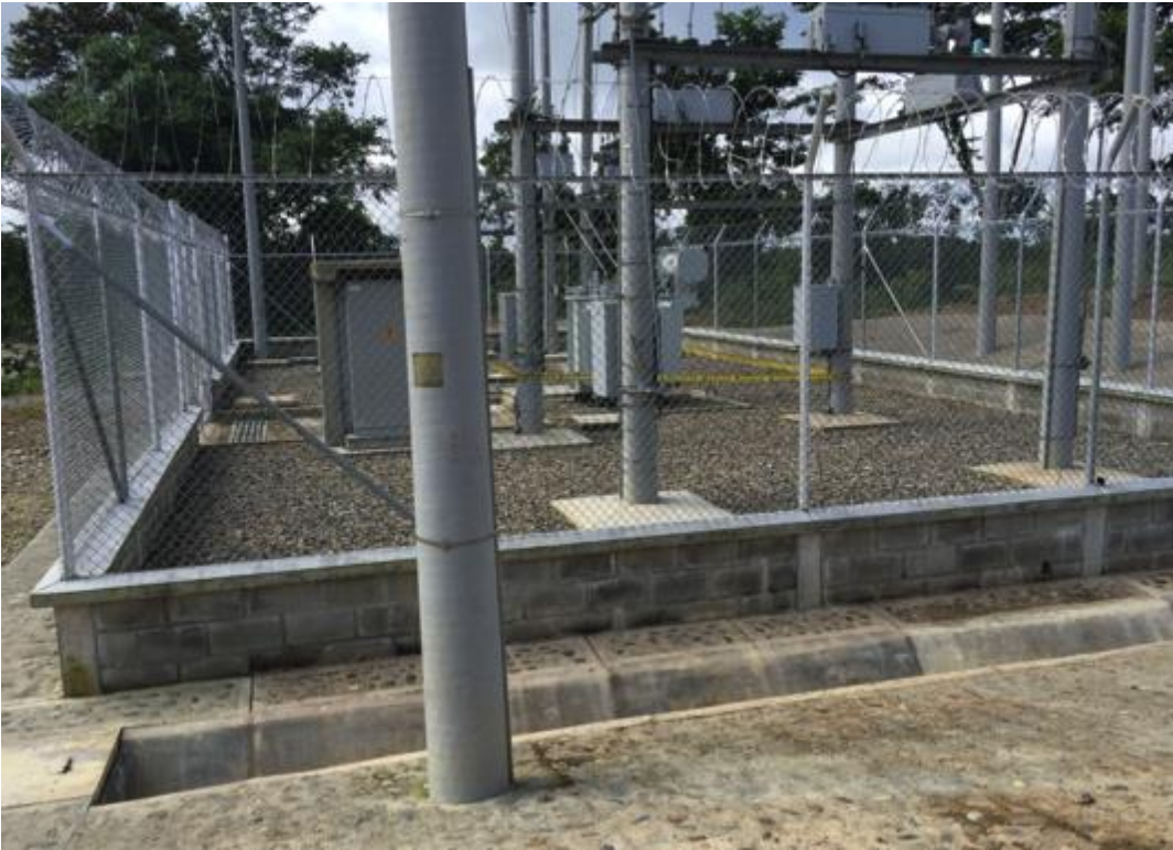
Fig 8 - Subestación de Chaquí (1000 kVA)
