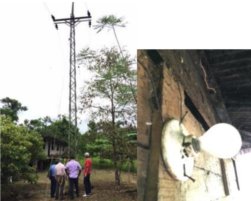
Fig 2 - Torres y cableado de 13.2 kV en Munguidó
