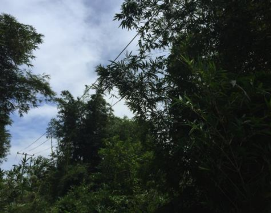
Fig 11 - Tendidos en Anchicaya con necesidad de mantenimiento
