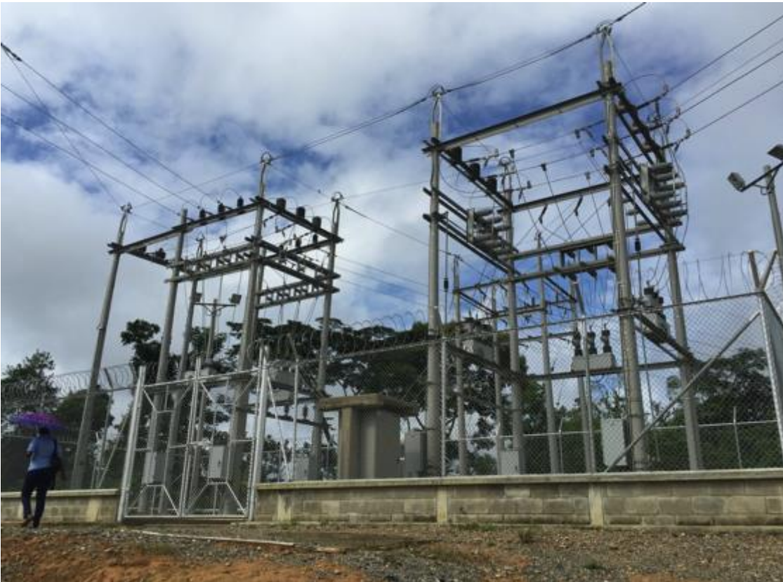
Fig 5 - Subestación de Chaquí (Istmina)
