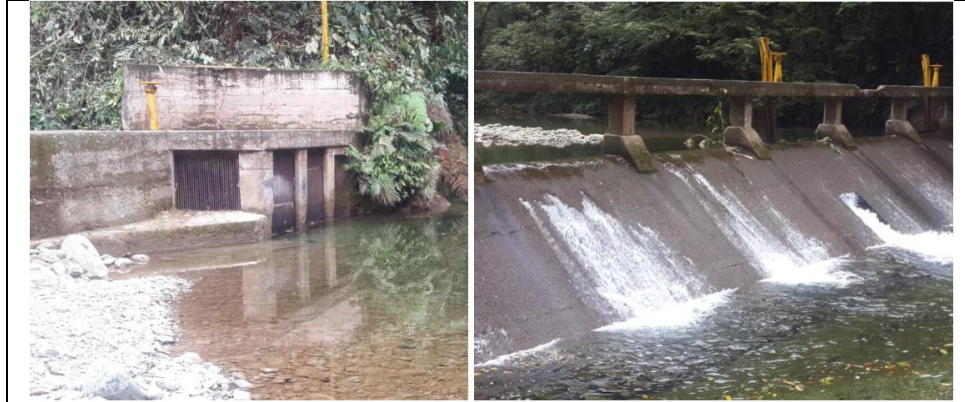
Figura 3.11. Bocatoma antigua (izquierda) y bocatoma nueva (derecha)
