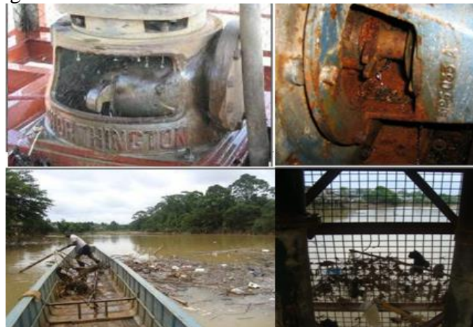
Figura 3.3. Problemas de la Bocatoma sobre el río Cabí.
