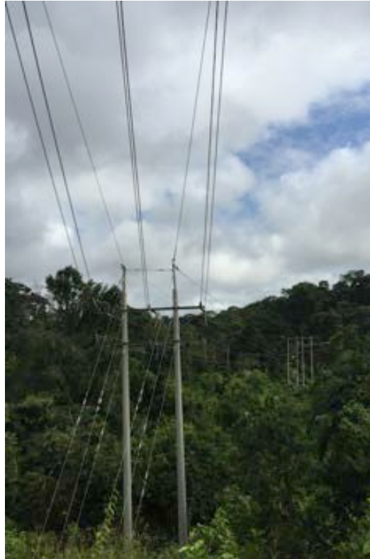
Foto 2: Línea de transmisión en 34,5 kV existente
