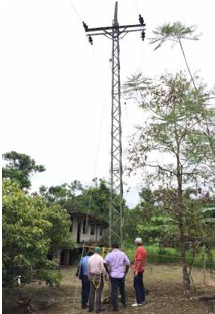
Foto 3: Línea de transmisión de 13,2 kV existente
