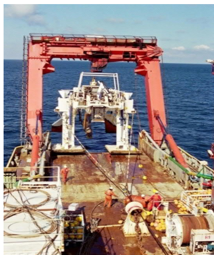
Figuur 4-19: Een typische installatieploeg
