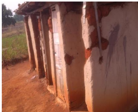
Latrine de Babessi
