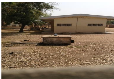
CMA de LAINDE (pas de clôture)
