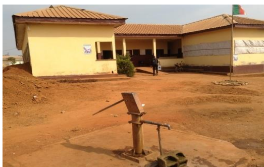
CMA de DANG (pas de clôture)
