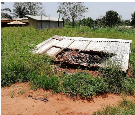
Photo 3 : Incinérateur et fosse à cendre non conforme aux normes de l'OMS du Centre de Santé de Difolo
