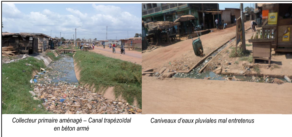
Photo 3 : Etat des ouvrages d'assainissement
