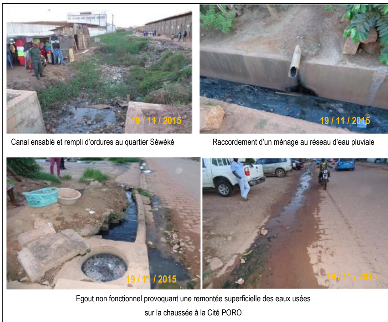
Photo 9 : Etat des ouvrages d'assainissement
