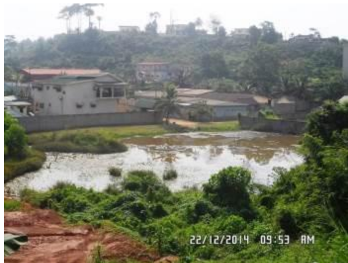
Photo 4 : Bassin d'orage situé au quartier Nitro
