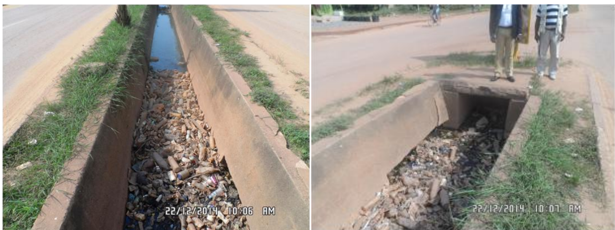
Photo 2 : Ouvrage de drainage des eaux pluviales
