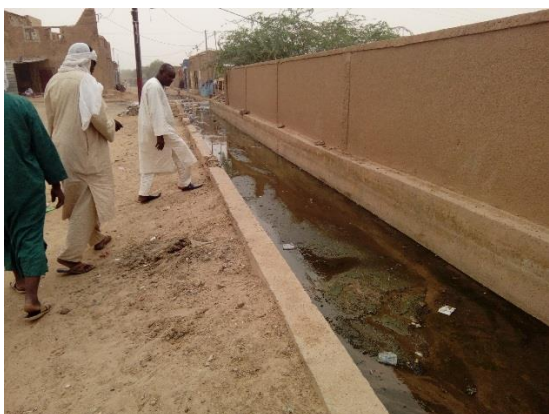
Site de construction de caniveaux à Agadez
