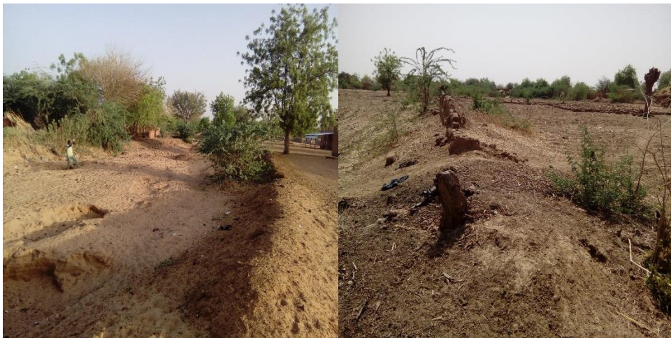
Sites de digue de protection des villages de Kiara et de Takorka
