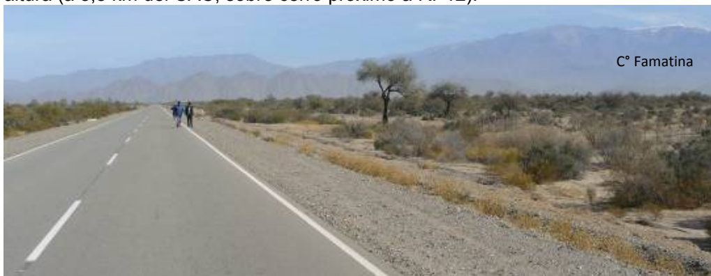
Foto N°7: Vista hacia el Oeste sobre RP12 (0°)
