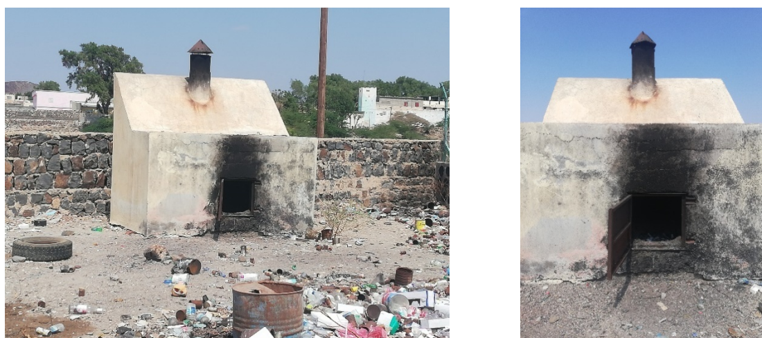
Image V-16 : Incinérateur artisanal au CMH de Dickhil
