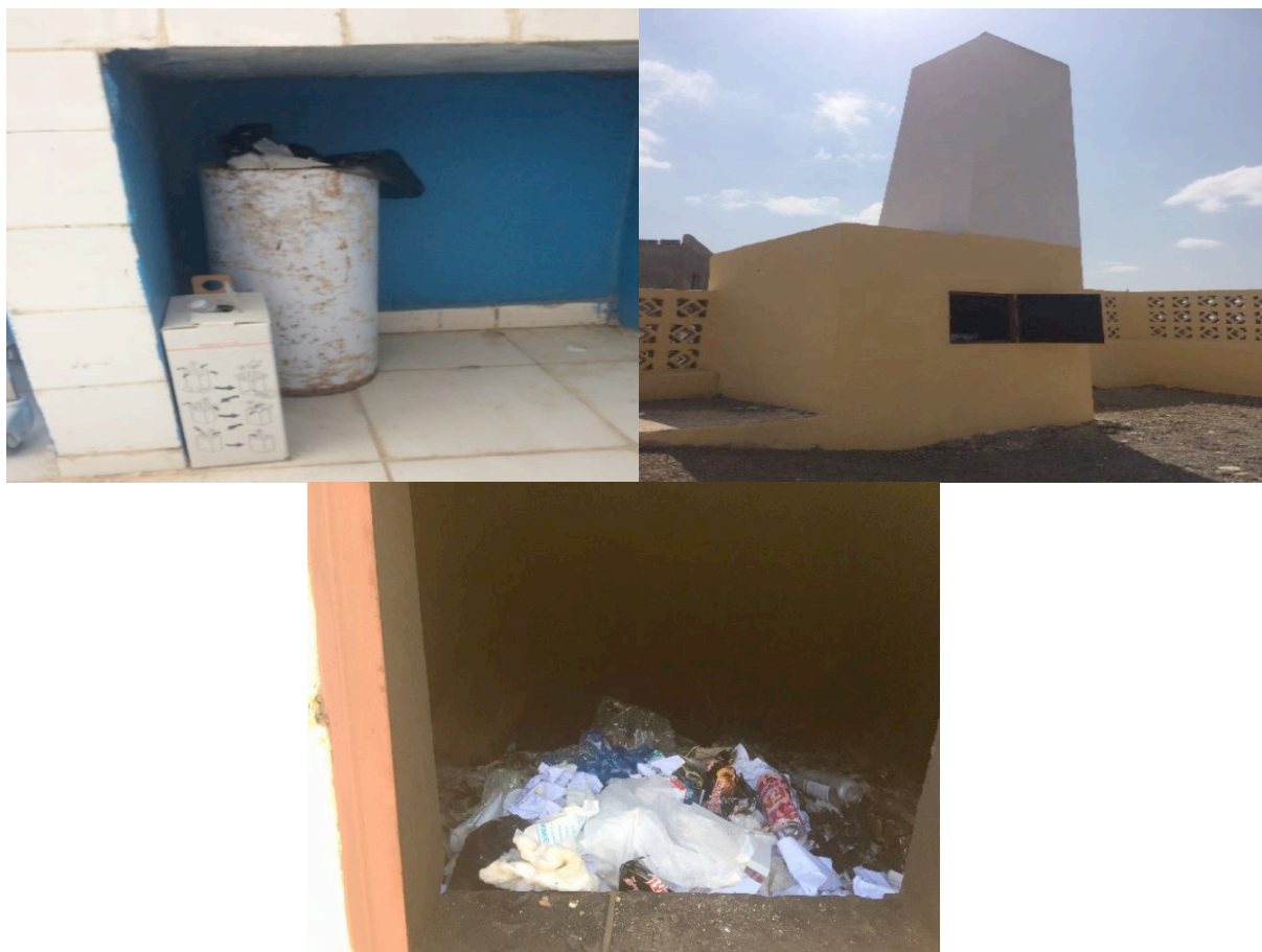
Image V-23 : Collecte des déchets (à gauche), incinérateur (à droite) et déchets à l'intérieur de l'incinérateur (en bas) à Ali Addé.
