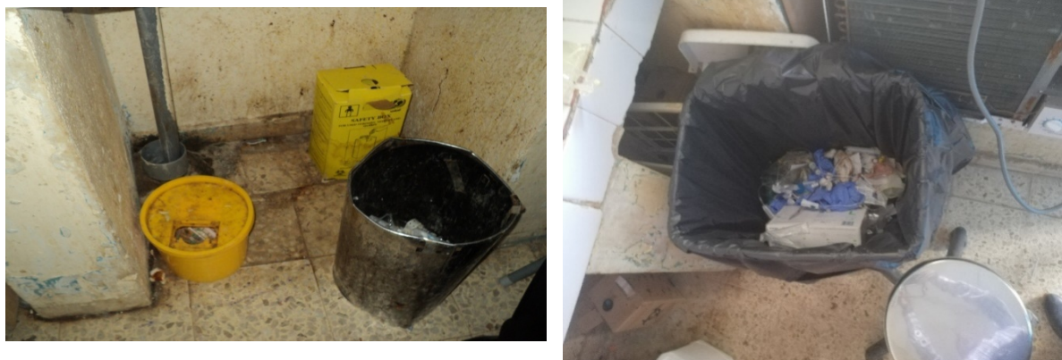
Image V-5 : Une boîte de sécurité dans un état délabré dans un coin insalubre du centre (à gauche) et une poubelle sans couvercle réservées aux ordures ménagères contenant de DBM (à droite).
