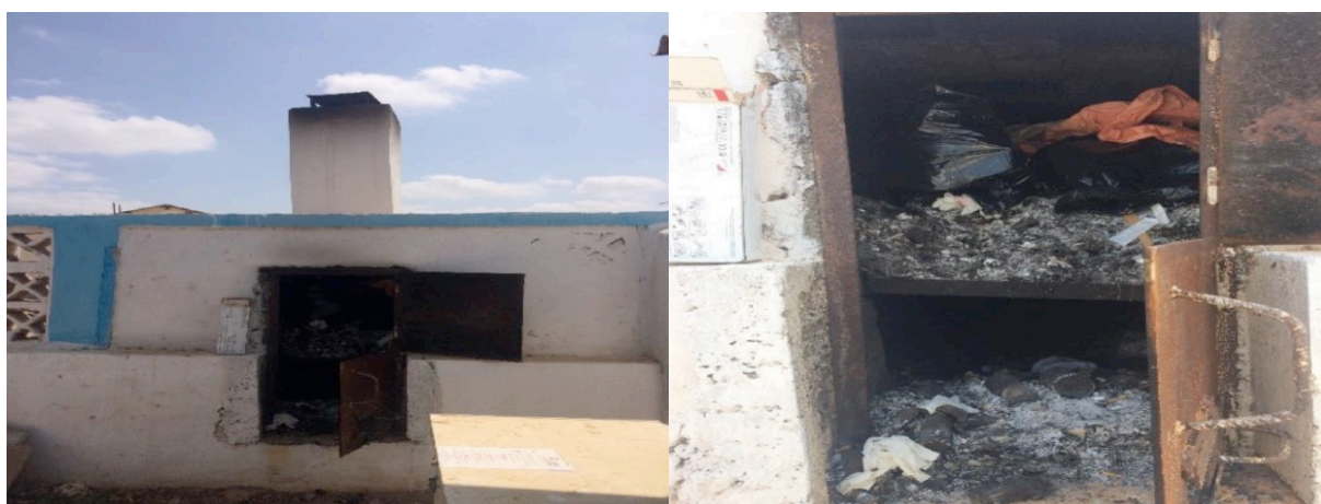
Image V-24 : Incinérateur du poste de santé de Holl Holl (à gauche) à et son intérieur (à droite).
