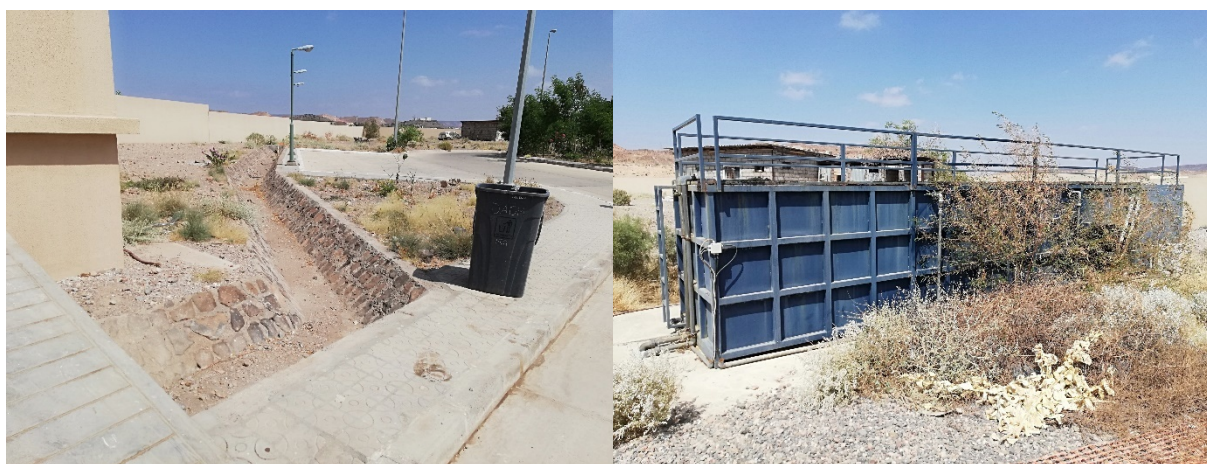
Image V-22 : Système d'évacuation des eaux pluviales (à gauche) et à droite une mini station de traitement d'eaux usées.
