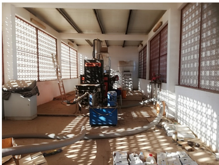
Image V-38 : Incinérateurs électrique de l'hôpital
