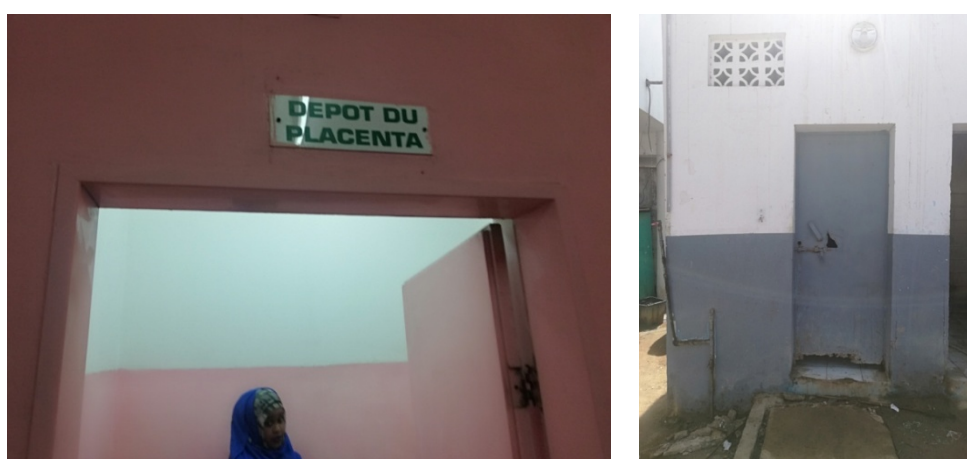
Image V-35 : Salle de dépôt du placenta (à gauche) ; locale réservé pour la conservation du placenta (à droite).
