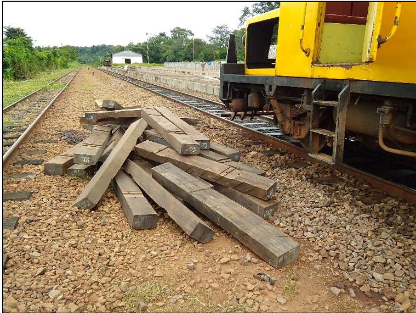
Figure 11 : Traverses en bois remplacés
