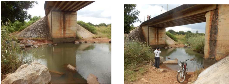
Figure 9: Pont au Pk 881+051
