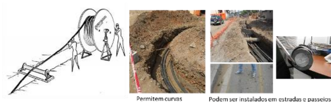
Figura 6-2: Processo de instalação de cabos subterrâneos
