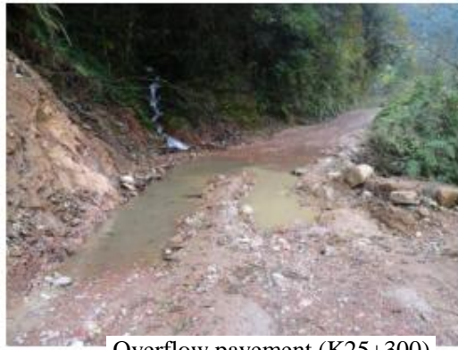
Overflow pavement (K25+300) 溢水路面 (K25+300)
