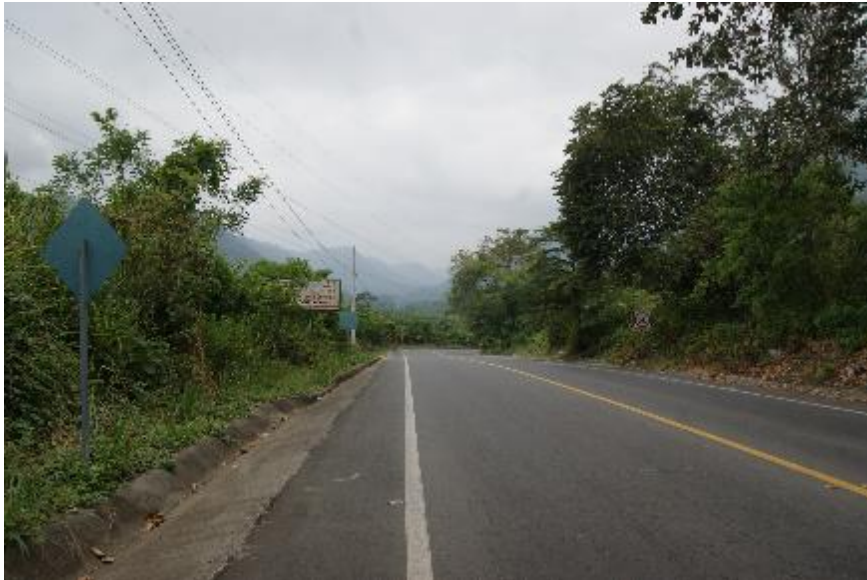
Vista de una de las vías por donde se instalará la línea de conducción
