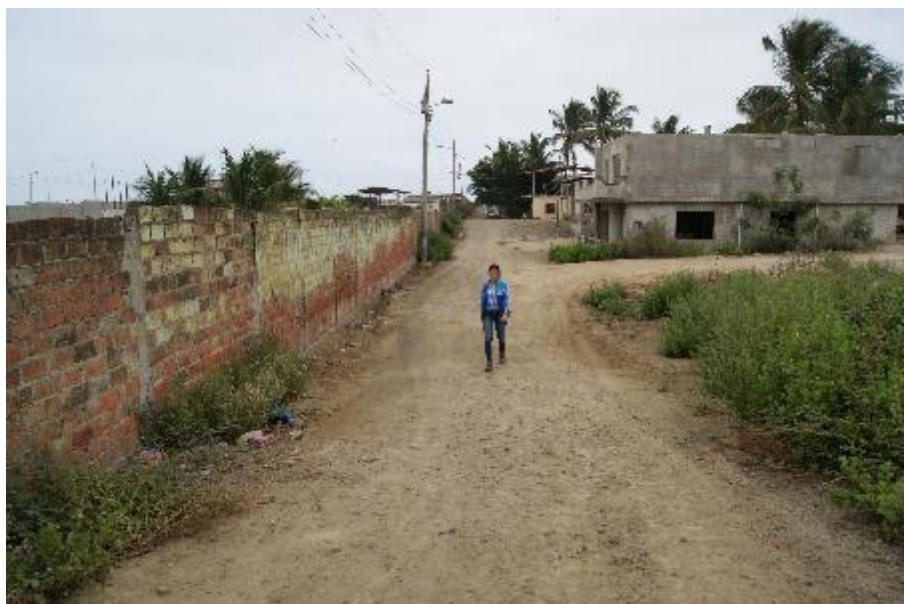
Vista de una típica calle donde se instalará alcantarillado sanitario
