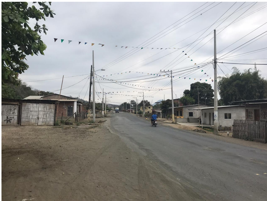
Fotografía No. 9: típica calle de Colón, por donde se instalarán redes de agua potable y alcantarillado
