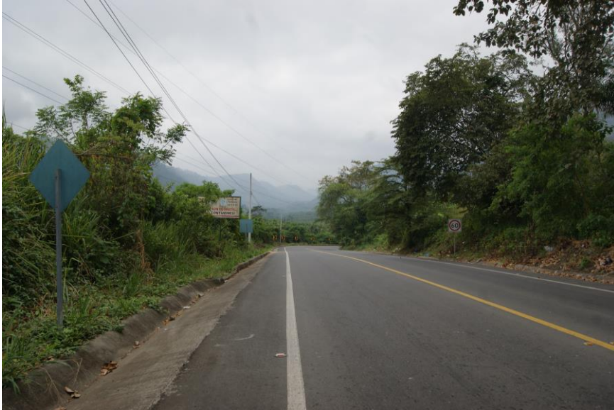
Fotografía No. 5: Vista de una de las vías por donde se instalará la línea de conducción
