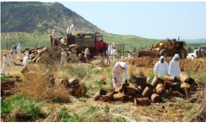
Figure 13 : Opérations de sécurisation sur le Cimetière de Niogoméra
