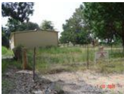
Figure 6 : Côté nord du Magasin
