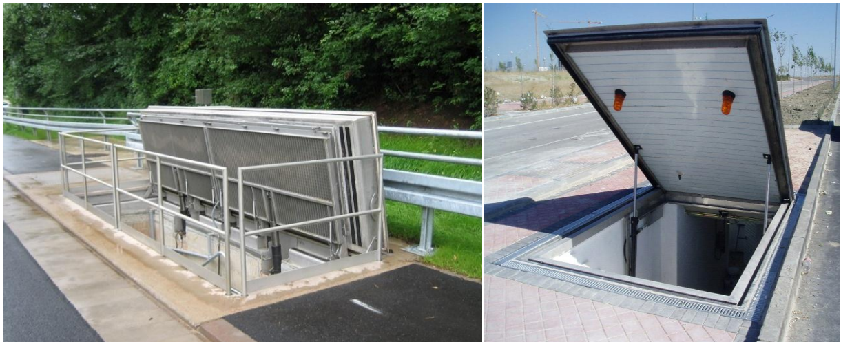
Figura 4-18 Ejemplos de mecanismo de apertura hidráulico
