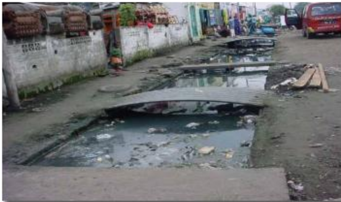
Figure 5 : Une vue des problèmes d'assainissement de Brazzaville
