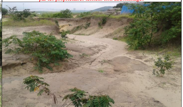
Site de Kintélé : Erosion – Terrain sableux
