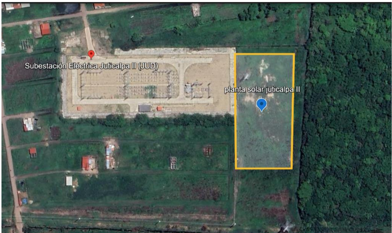
FIGURA 5 PROYECTO FOTOVOLTAICO, JUTICALPA, OLANCHO, HONDURAS
