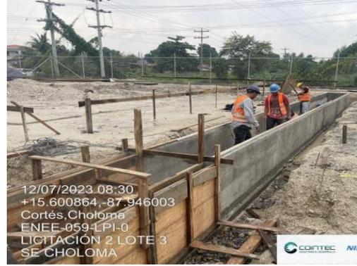
Construcción de canaleta cable de control.
