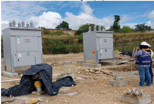
**Instalación de Interruptores de media Tensión en Bahía de 34.5 kv**
