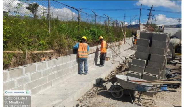
Fundición de solera intermedia en muro perimetral de bloque
