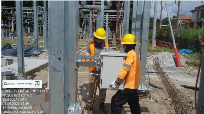
Montaje de gabinetes de control de seccionadores 13.8 KV
