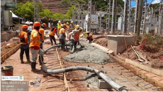
Colocación de concreto hidráulico en calle de acceso a transformador trocha L.D.
