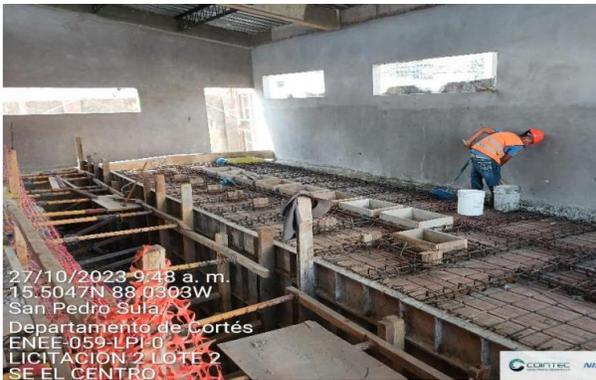
Armado y encofrado de vigas en edificio de control
