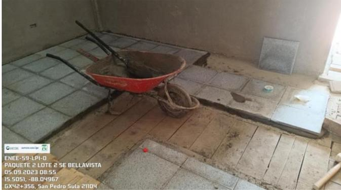
Colocación de terrazo en piso del edificio de control de la subestación
