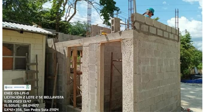
Levantamiento de paredes en la caseta de vigilancia de la subestación.
