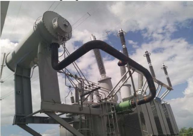
**Tuberías contraincendios de autotransformador - SPSS**
