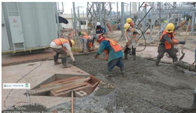
Colocación de concreto hidráulico en calle, entre las estaciones 0+100-0+130 bahía izquierda trocha central
