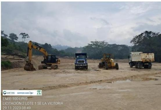
Trabajo de terracería para elevar niveles de plataforma de la subestación DETENIDO por saturación excesiva del suelo y drenaje de agua de infiltración por lluvias.
