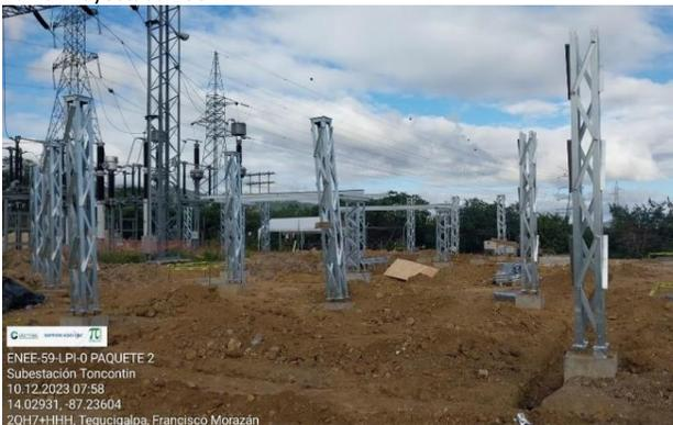
Montaje de estructuras metálicas para equipo menor
