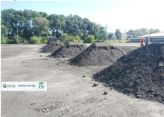
Relleno de material selecto por capas en la plataforma
