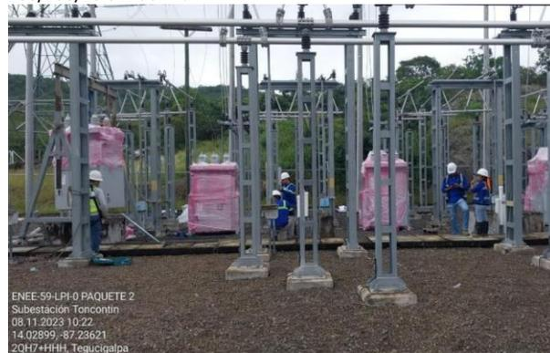
Montaje de cuatro Interruptores de media tensión en Bahía 13.8KV
