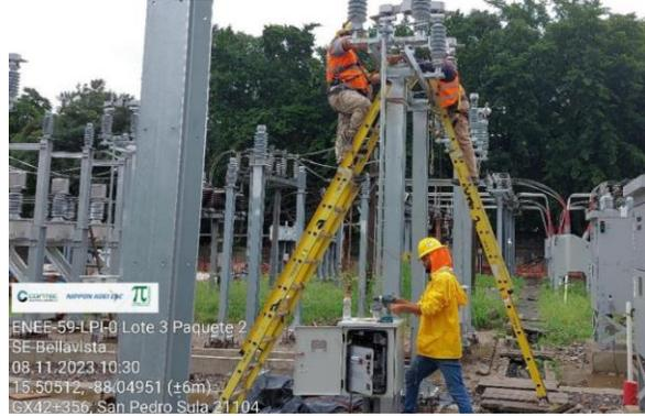
Se realizan trabajos en la instalación de interruptores por lo que se verifique el equipo de protección personal.
