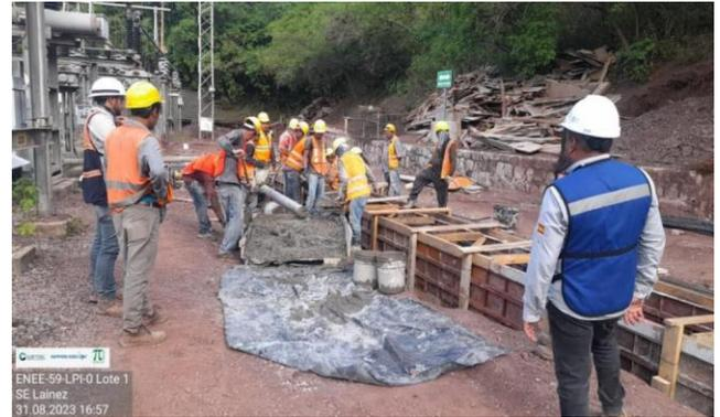
Obra Civil. Colado de losa inferior de canal perimetral de retención de aceite de transformador
