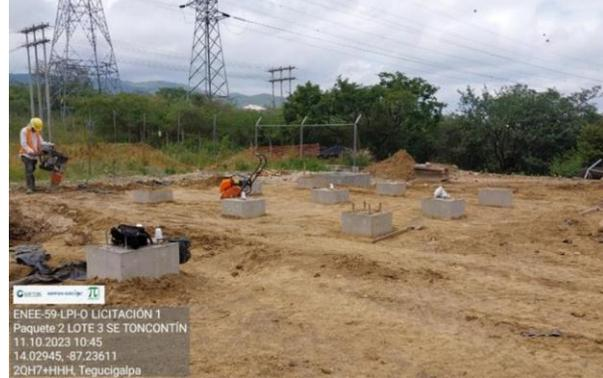
Relleno y Compactado de Material Selecto en área de Cimentaciones de Bahía Proyectada 138kv.
