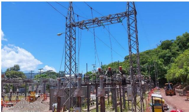
Despeje línea de 69kV L-421 para realizar trabajos en losa de concreto de la sala de control.
