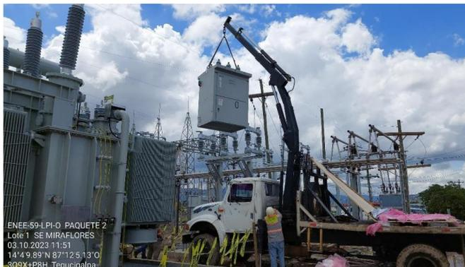
Montaje de interruptor tanque muerto 13.8kV 3000<sup>A</sup>, en nueva bahía 13.8kV salida del nuevo transformador T-553
