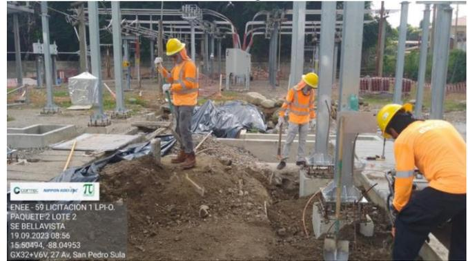
Instalación de Puesta a Tierra para Interruptor 13.8kV
