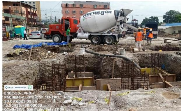
Fundición de Cimentaciones para equipo mayor y menor de la subestación.
