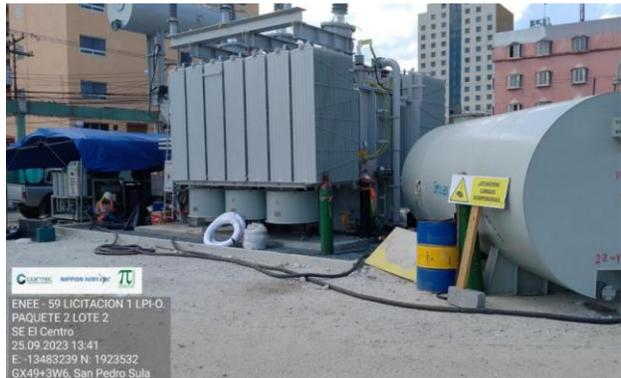
Proceso de llenado de Aceite Dieléctrico al Transformador de Potencia
