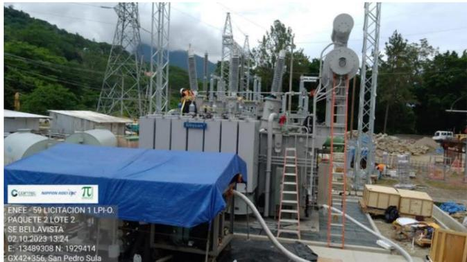
Preparación para Aplicación de Vacío y Recirculación de Aceite al Transformador de Potencia
