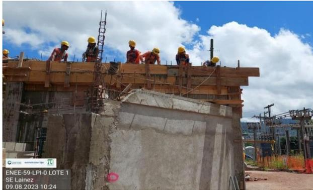
Colado de vigas en eje V1 en ampliación sala de control
