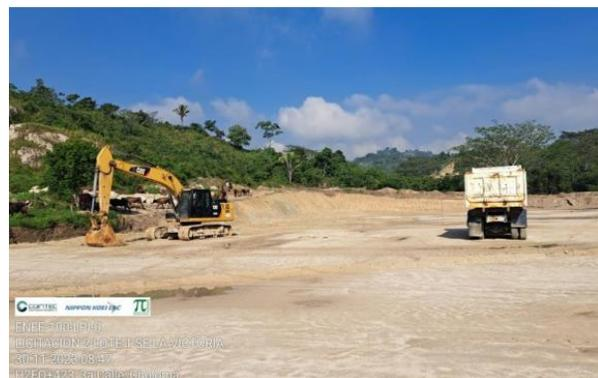
Trabajo de terracería para elevar niveles de plataforma de la subestación DETENIDO por saturación excesiva del suelo y drenaje de agua de infiltración por lluvias.
