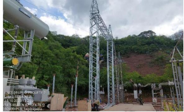
Montaje de pórtico salida línea Miraflores-Lainez, pedestales e interruptor tanque muerto en bahía de 138kV
