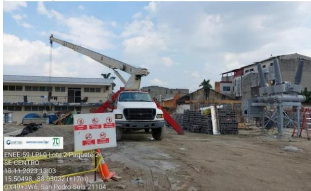
Montaje de Bushing a Interruptor 138 KV
