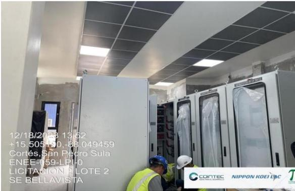
Instalación de Cielo Falso en sala de control
