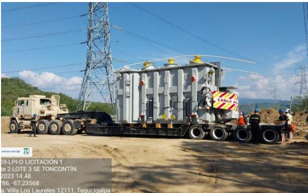
Transporte y Ubicación de la Cuba del Transformador de Potencia a la Bahía Proyectada 230kv.
