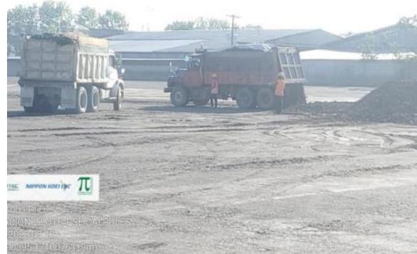
Trabajo de terracería con material importado para elevar niveles de plataforma de la subestación
