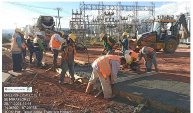
Colocación de concreto hidráulico en calle, entre las estaciones 0+100-0+130
