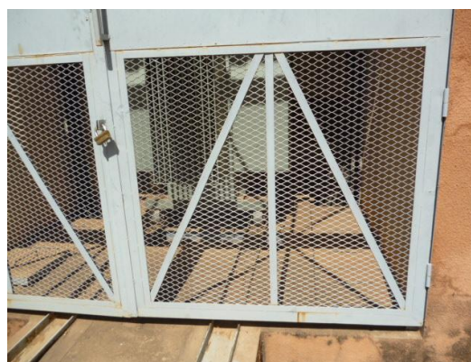
Photo 4 : Transformateur de 5 MVA
