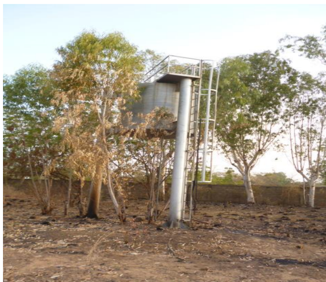
Photo 13 : Forage et château d'eau de la centrale existante
