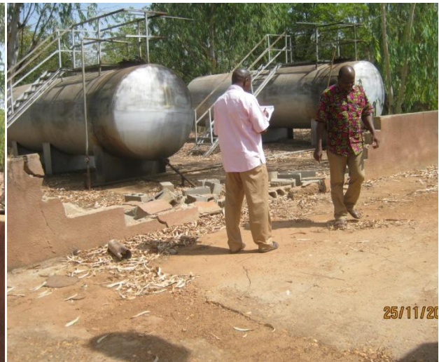
Photo 2 : Inspection des cuves par la mission
