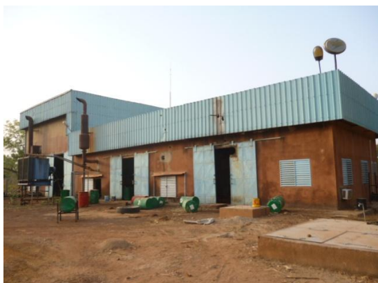
Photo 1 : Le bâtiment abritant les groupes
