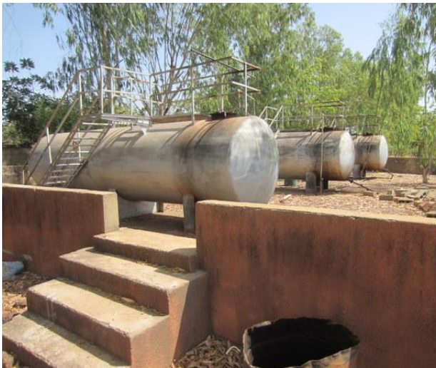
Photo 9 : Bacs de rétention des cuves de stockage du DDO
