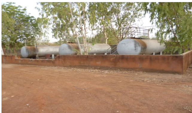
Photo 5 : Le parc à combustible
