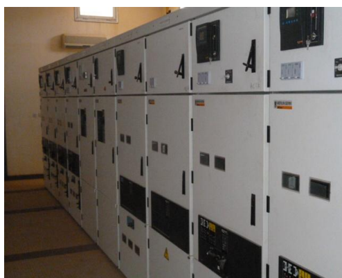
Photo 3 : Cellules de 20kV
