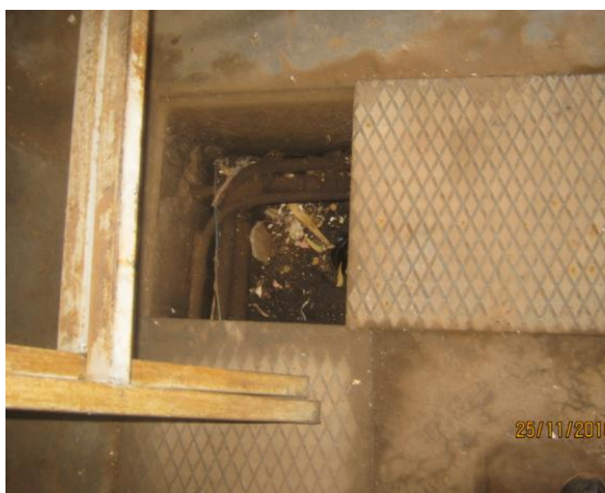
Photo 7 : Partie du réseau de collecte de boues
