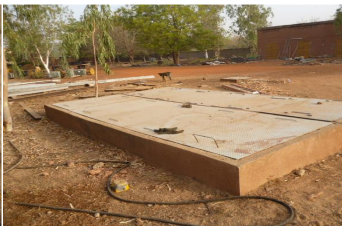
Photo 8 : Partie supérieure du bassin de décantation
