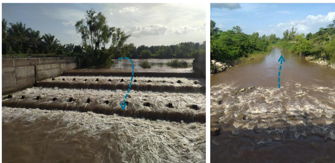
Figura 19. Canal La Fragua en su conexión con el río Ulúa.
