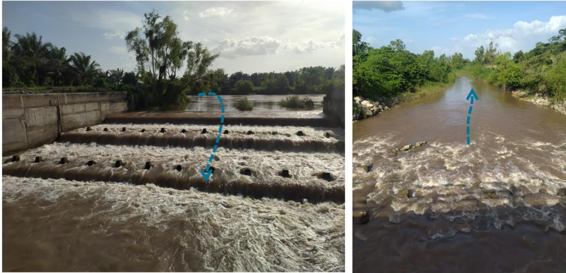
Figura 4.9. Canal La Fragua en su conexión con el río Ulúa.
