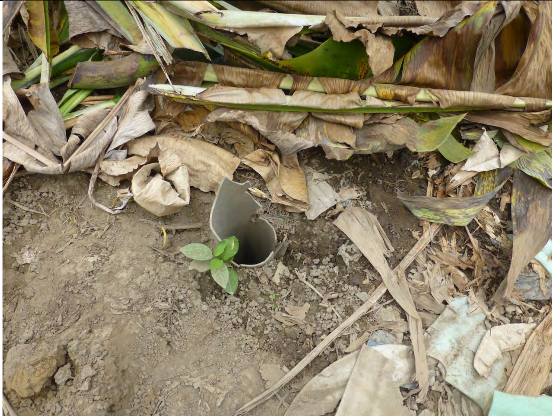
Casing (app 12 pulgadas diámetro) in open agricultura área of banana plantación, damaged and open to inflow from surface wáter.
