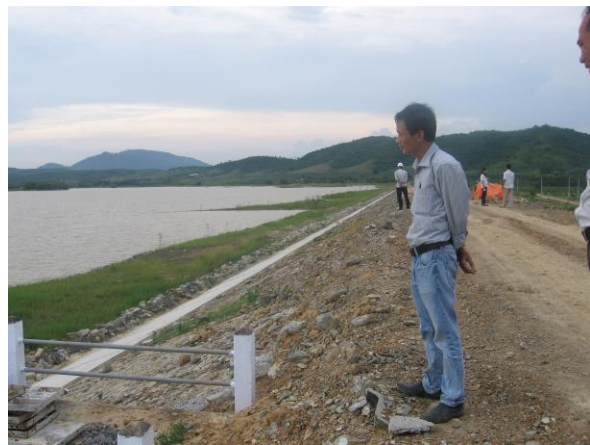
At Du Du Dam –Du Du Subproject
