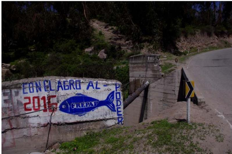
**Figura 23:** Tubería existente que dirige las áreas residuales a las lagunas de oxidación.
