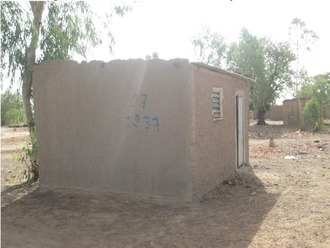
Photo 6 : Maison recensée sur le site de la mairie de Saponé
