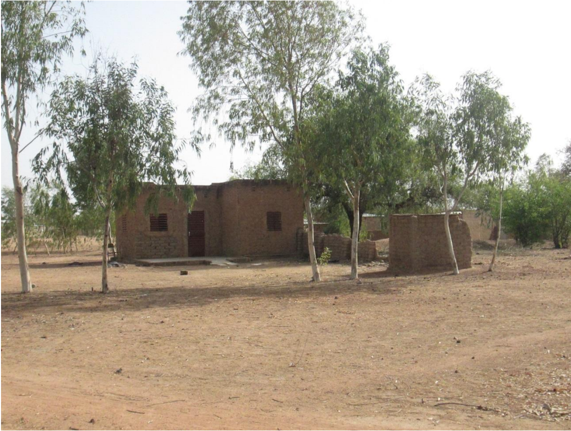
Photo 7 : Maison recensée sur le site de la mairie de Saponé
