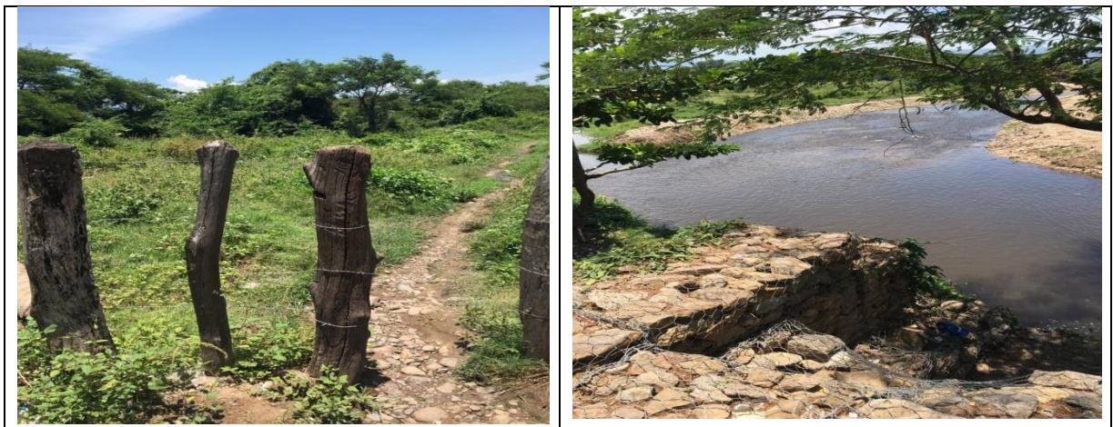
FIGURA 6 PASO TUBERIA RÍO RANCHERIA
