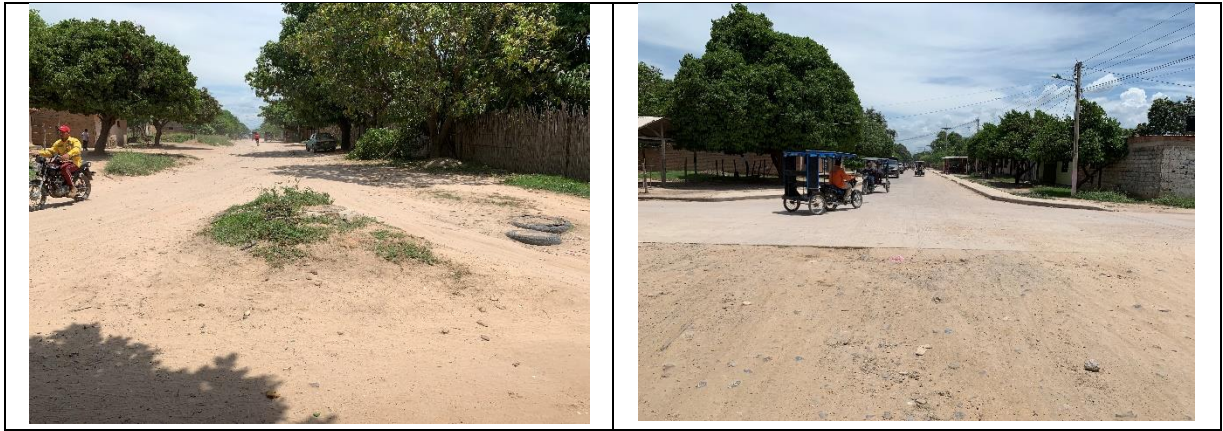
FIGURA 15 Estado actual de las vías y fachadas de predios en Fonseca.
