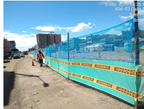
Cerramiento perimetral de obra
