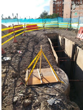
Señalización de Excavaciones y entibados
