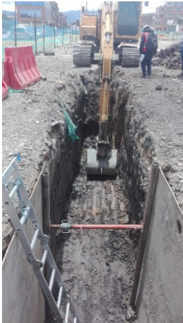
Señalización de Excavaciones y entibados
