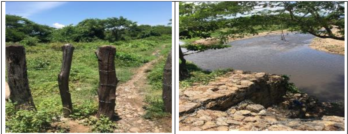
Figura 6 Paso Tubería Río Ranchería Fuente: Grupo Consultor Ambiental y Social, 2019
