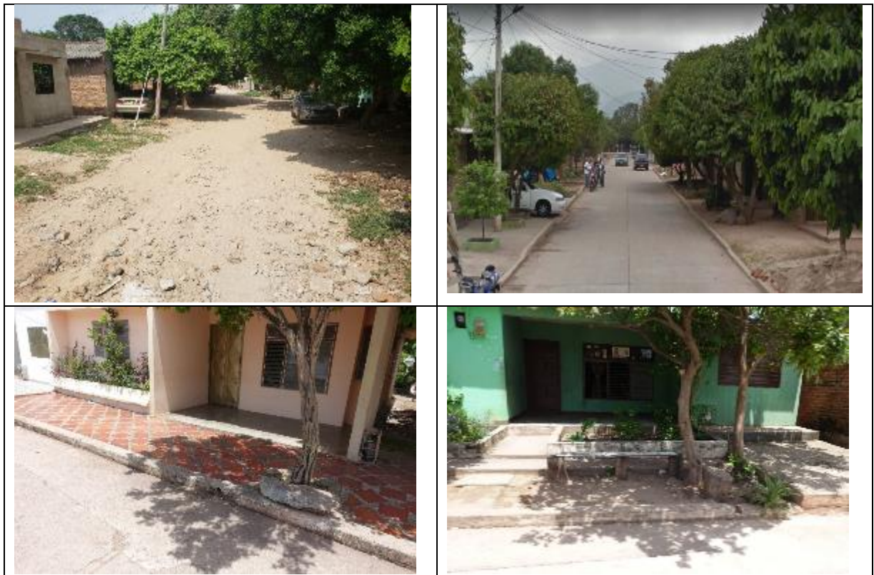
Figura 10 Estado actual de las vías y fachadas de predios en Urumita
