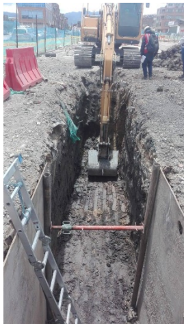
Señalización de Excavaciones y entibados
