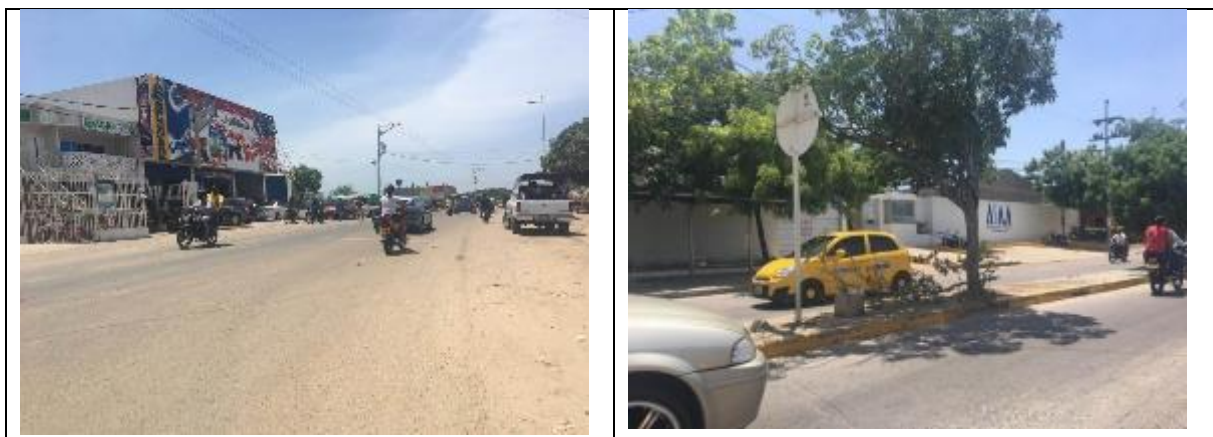
Figura 19. Estado actual de las vías y fachadas de predios en Riohacha.
