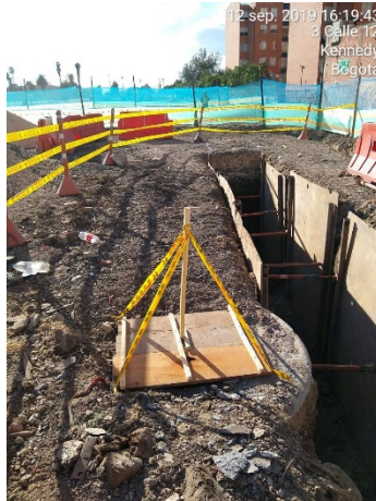
Señalización de Excavaciones y entibados
