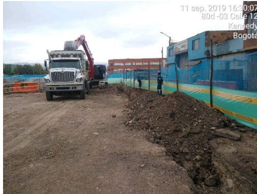
Cargue y transporte de escombros a sitio autorizado
