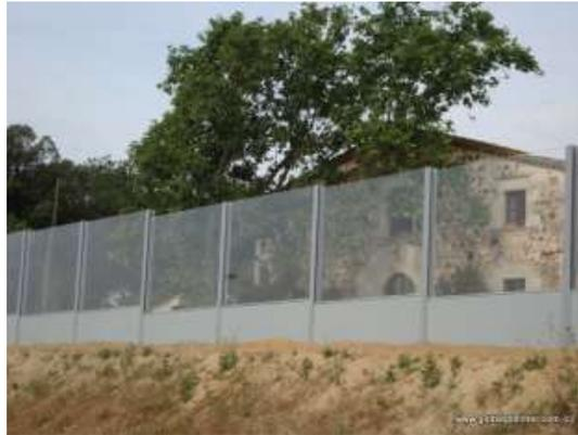
Ilustración 11: Barrera acústica artificial
