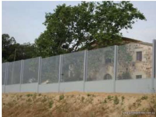
Ilustración 11: Barrera acústica artificial
