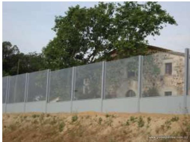
Ilustración 11: Barrera acústica artificial
