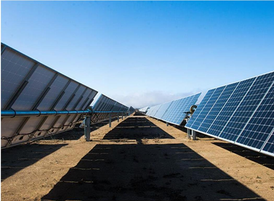
*Ilustración 4 - Seguidor 1V Nextracker*
