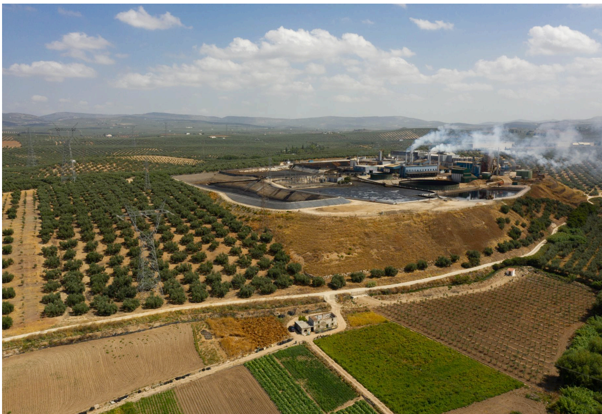
Foto 34 Detalle de la Subestación Eléctrica Egabrense.
