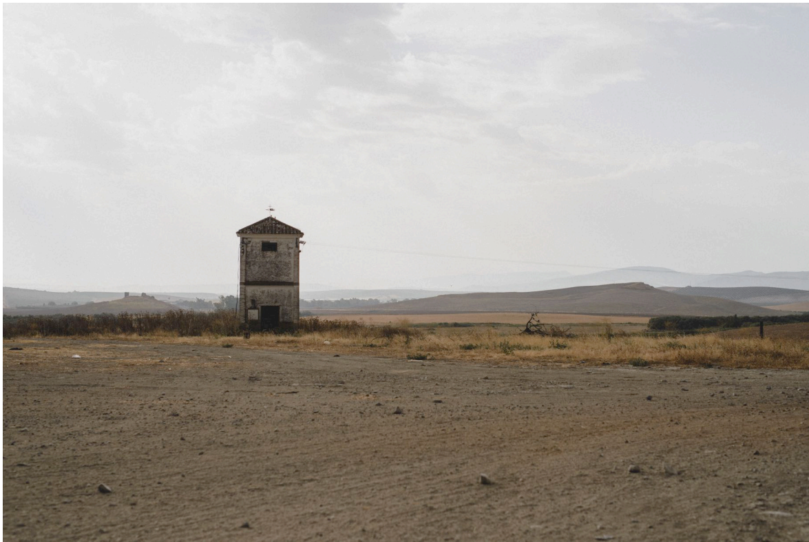
Foto 35 Caseta Transformador Mingohijo.
