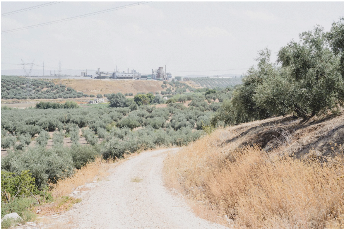
Foto 58. Subestación Eléctrica Egabrense desde el paraje La Retamosa.
