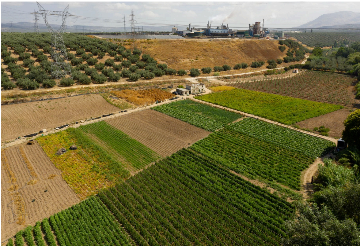
Foto 32 En primer plano las huertas a orilla del Río Cabra, apoyo de la línea “Espejo-Lucena” y al fondo la Subestación Eléctrica Egabrense.
