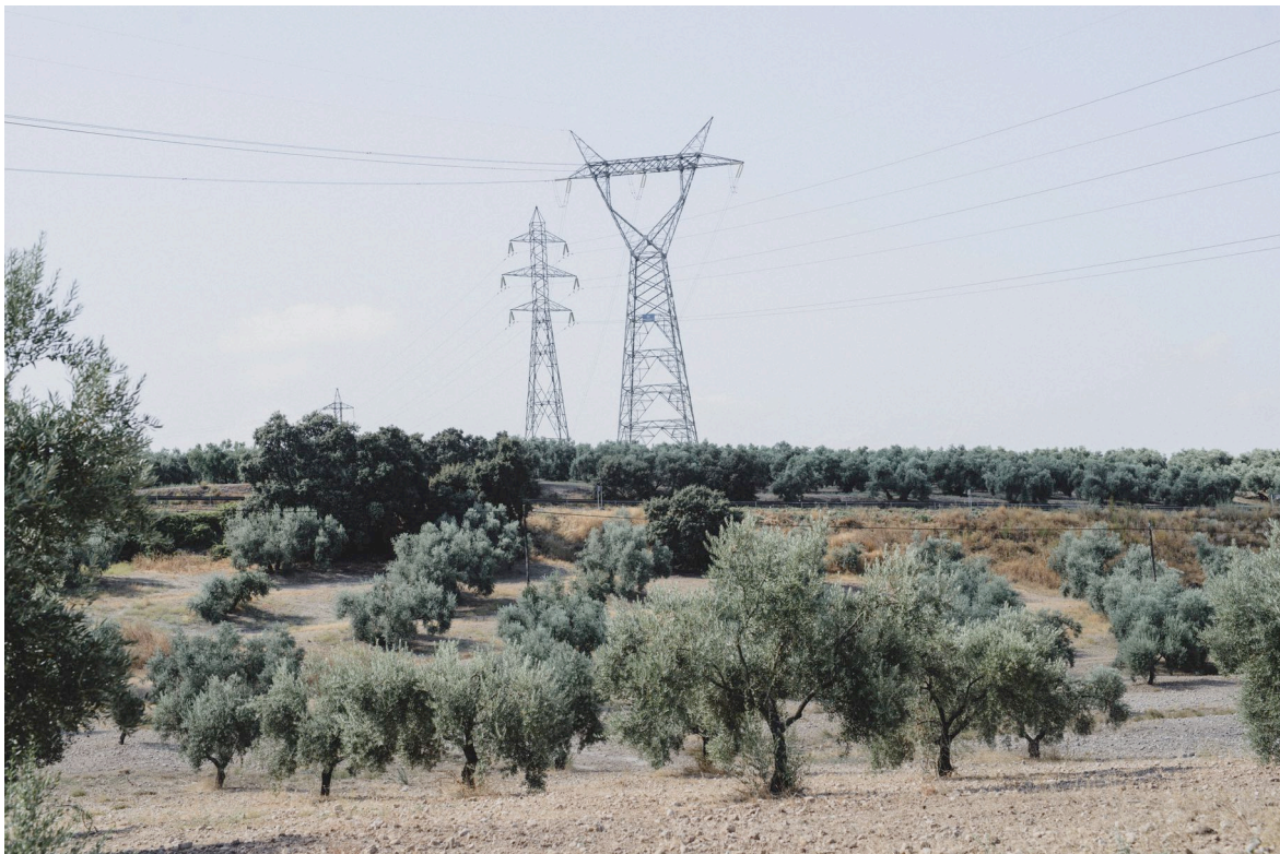
Foto 53. Cruce de la línea de "Espejo-Lucena" con la línea de 400 kV "Cabra-Roda de Andalucía".
