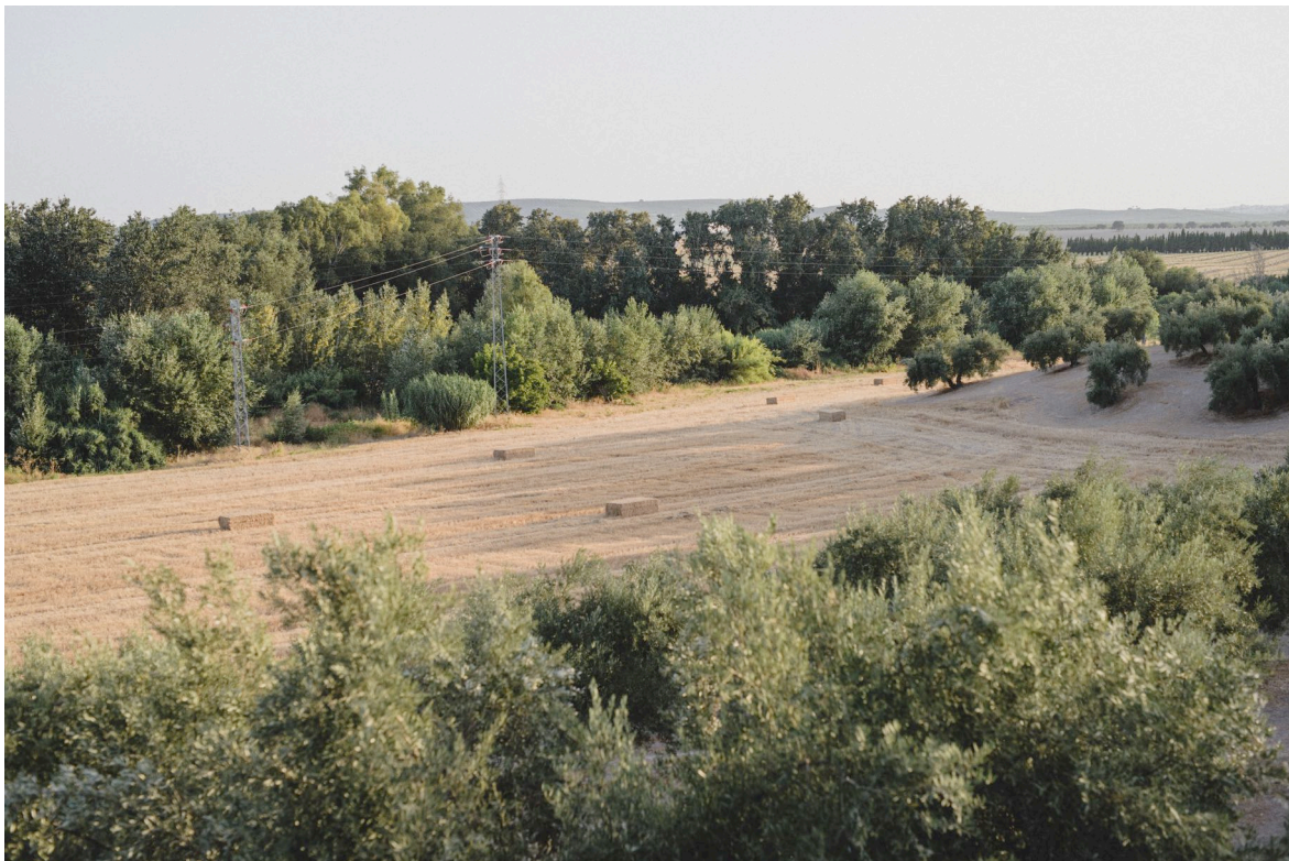
Foto 42 Detalle de derivación de línea con sistemas antielectrocución. Bosque de ribera del Arroyo de la Carchena al fondo.
