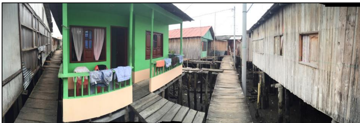
Sistema de “puentes y pasillos” en viviendas palafíticas
