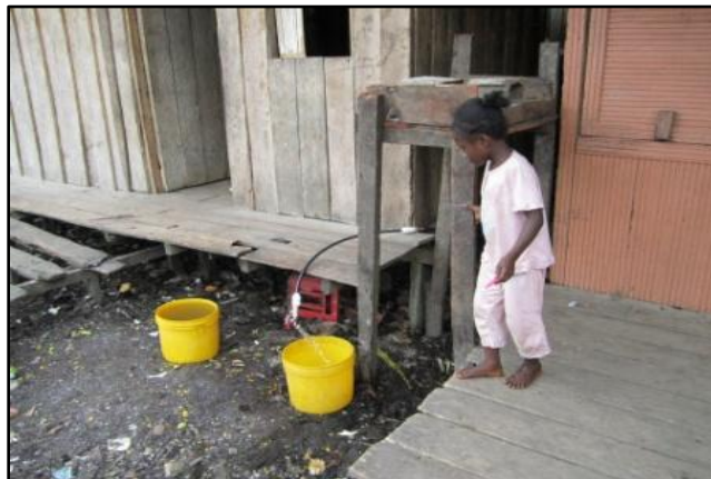
Conexión irregular al acueducto
