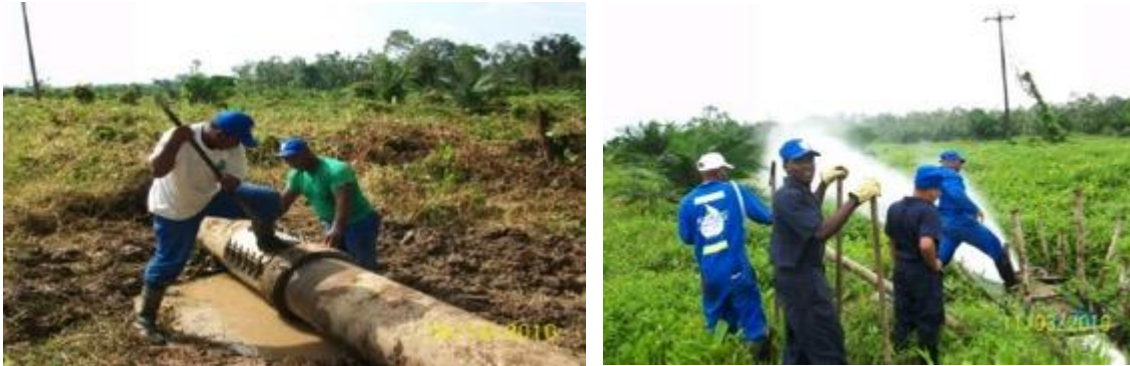
Fotografía 2-2 Reparaciones de tubería de aducción
