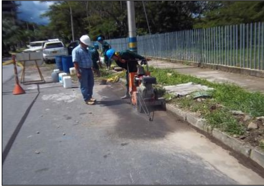
Fotografía 2-16 Corte de pavimento
