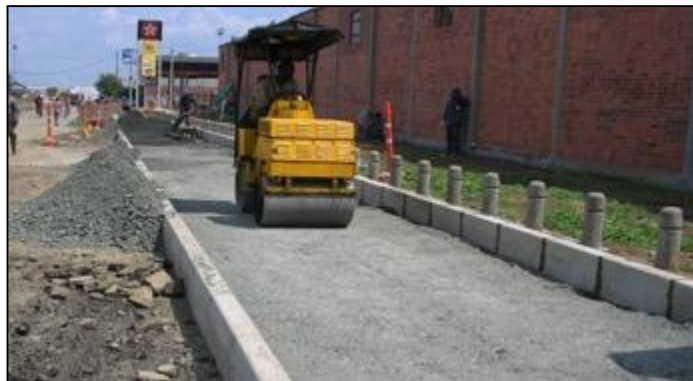
Fotografía 2-18 Instalación de base para adoquín en andén
