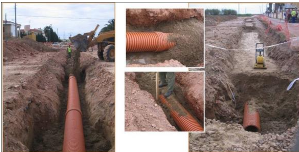
Fotografía 2-12 Relleno zanja para tubería
