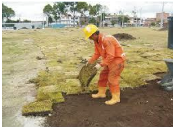
Fotografía 5-1 Revegetalización con cespedones
