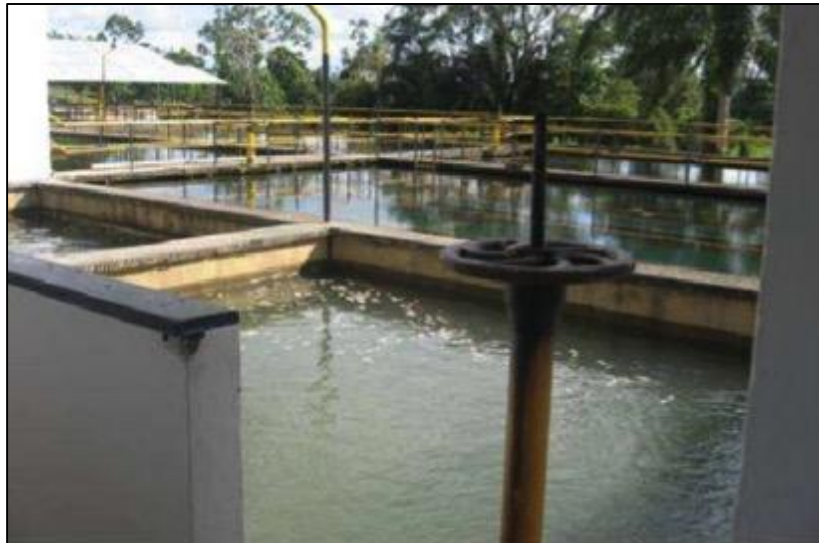
Fotografía 2-15 Planta de potabilización
