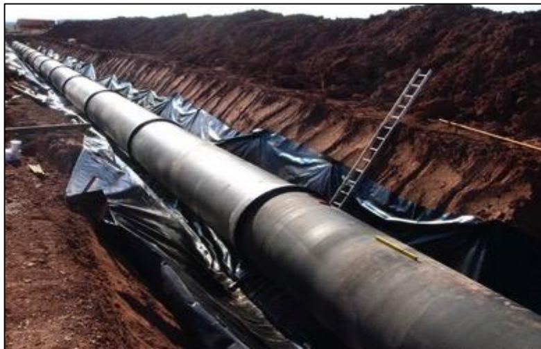
Fotografía 2-13 Tubería en hierro dúctil con juntas campana-espigo
