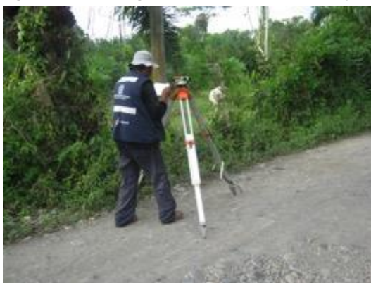
Fotografía 2-6 Topografía para la localización y replanteo
