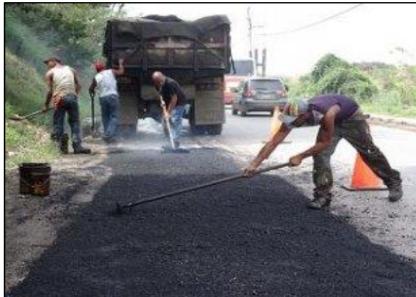
Fotografía 2-17 Instalación de asfalto
