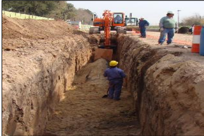
Fotografía 2-7 Excavación para acueducto
