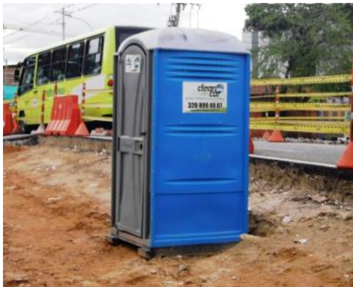
Figura 2-31 Baño portátil típico para manejo de aguas residuales
