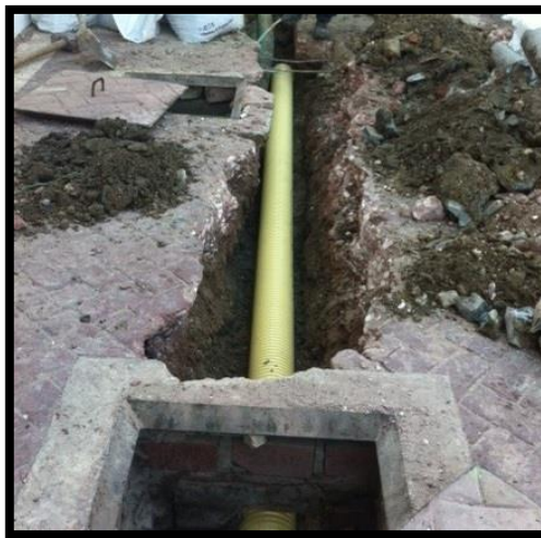
Imagen 5.4. Instalación de tubería a zanja abierta
